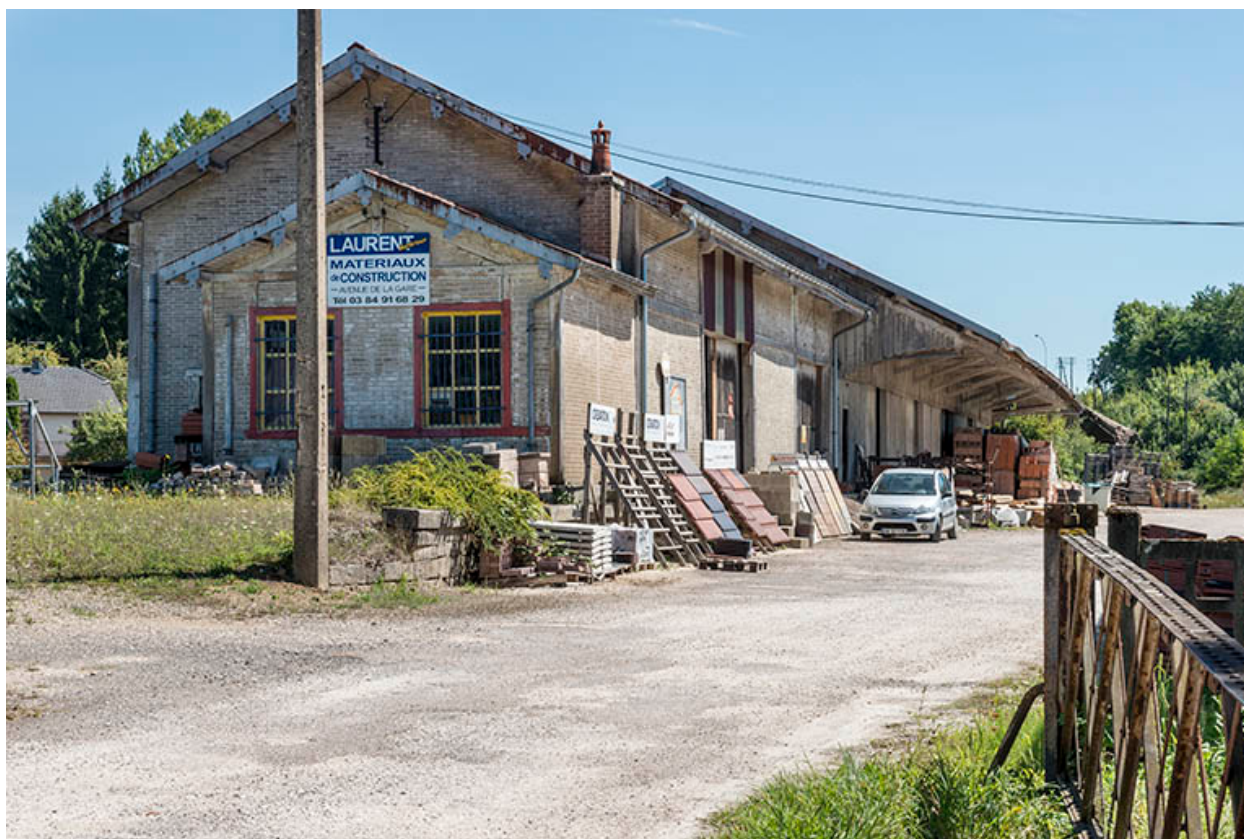
Vue depuis l'ancienne cour de la gare.
