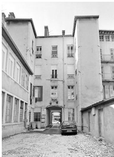
Façade postérieure et cour. Phot. Yves Sancey IVR43_20033900722X
