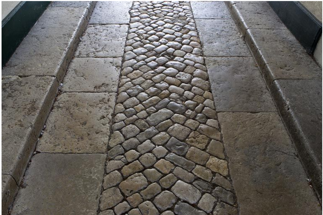
Passage couvert : sol de galets.
