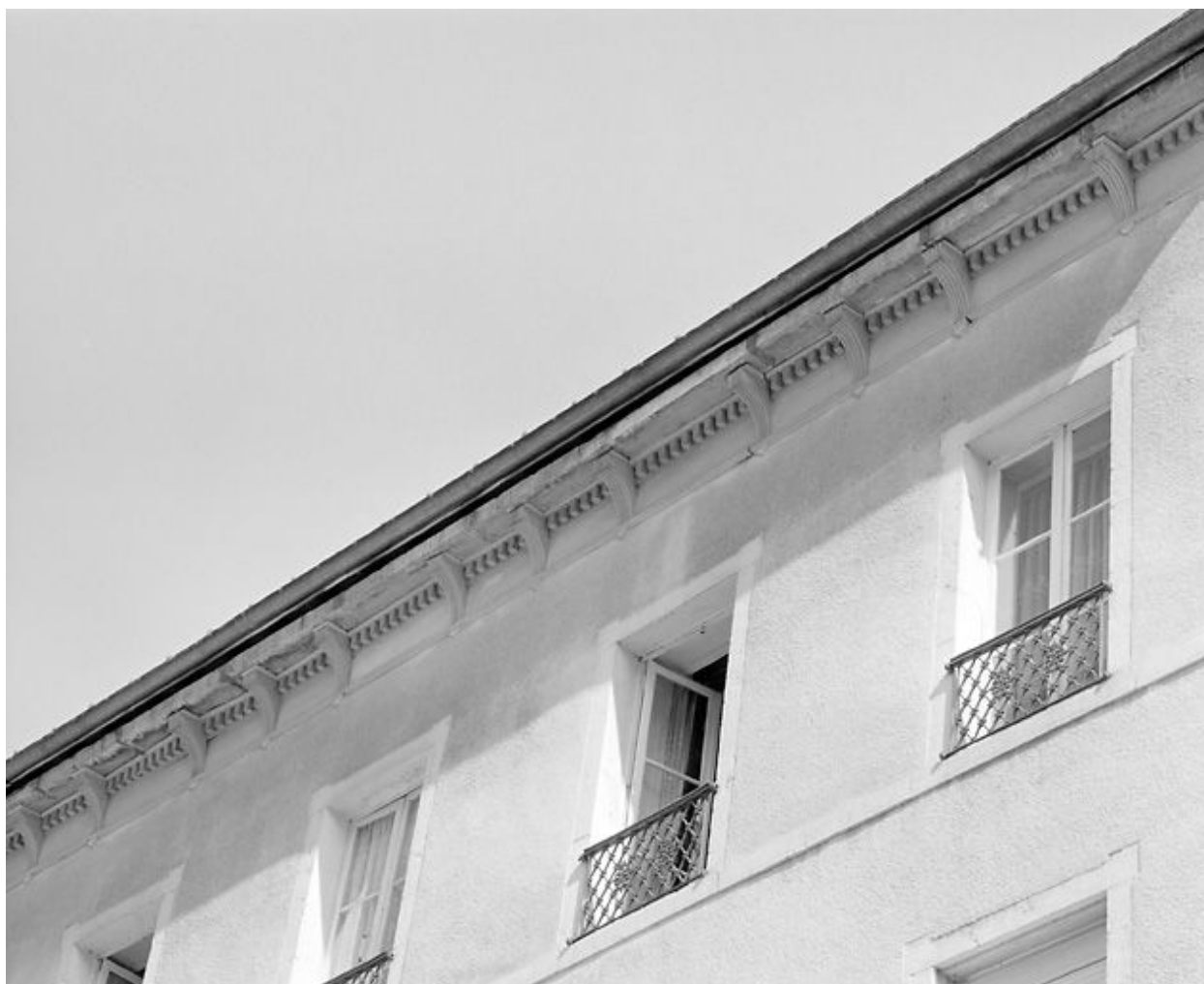
Façade antérieure : corniche.
