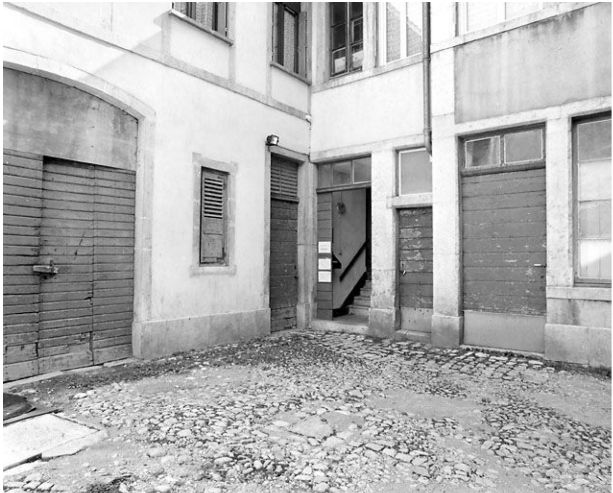
Angle de la remise et de l'atelier.
