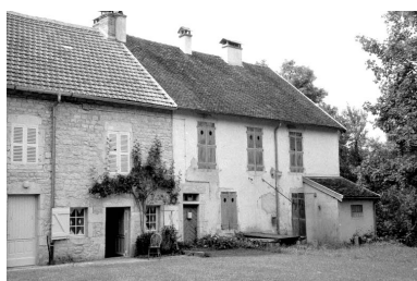
Façade postérieure du logement. Phot. Laurent Poupard IVR43_19933900541Z
