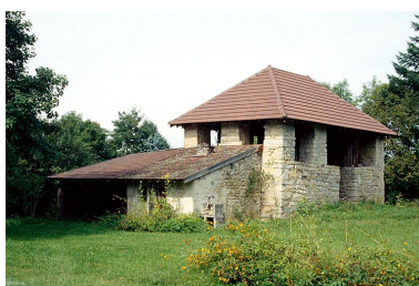
Four et bûcher, vus de trois quarts. Phot. Laurent Poupard IVR43_19933900543ZA
