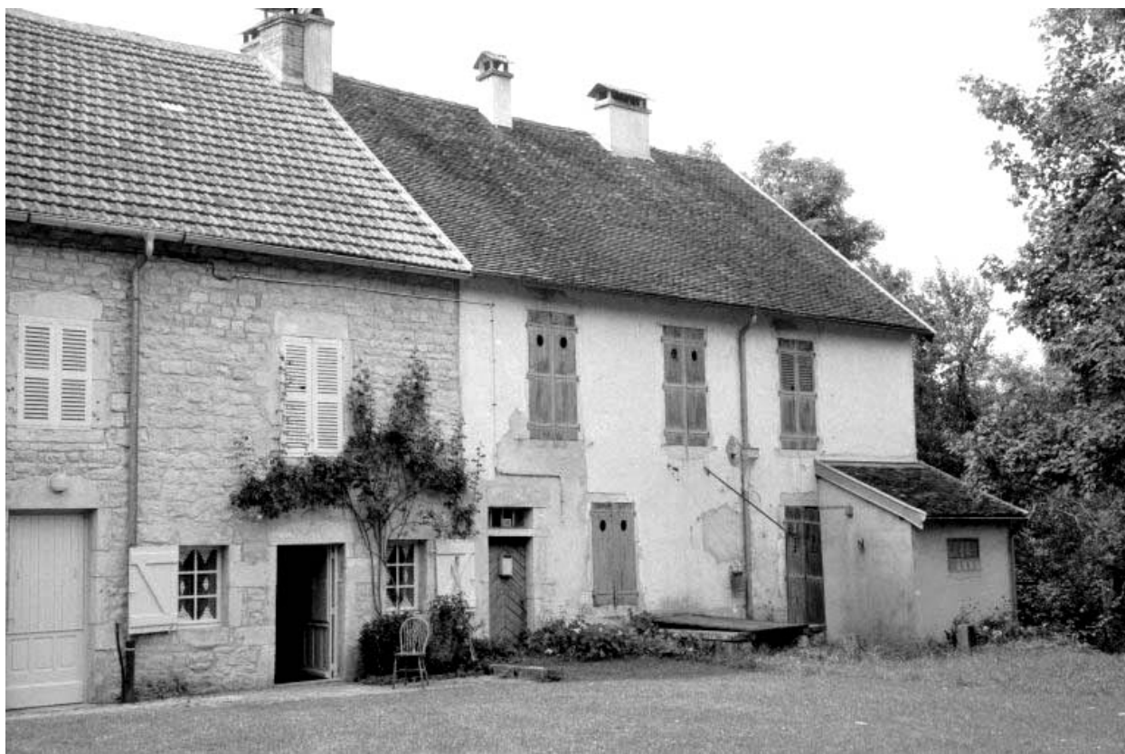
Façade postérieure du logement.
