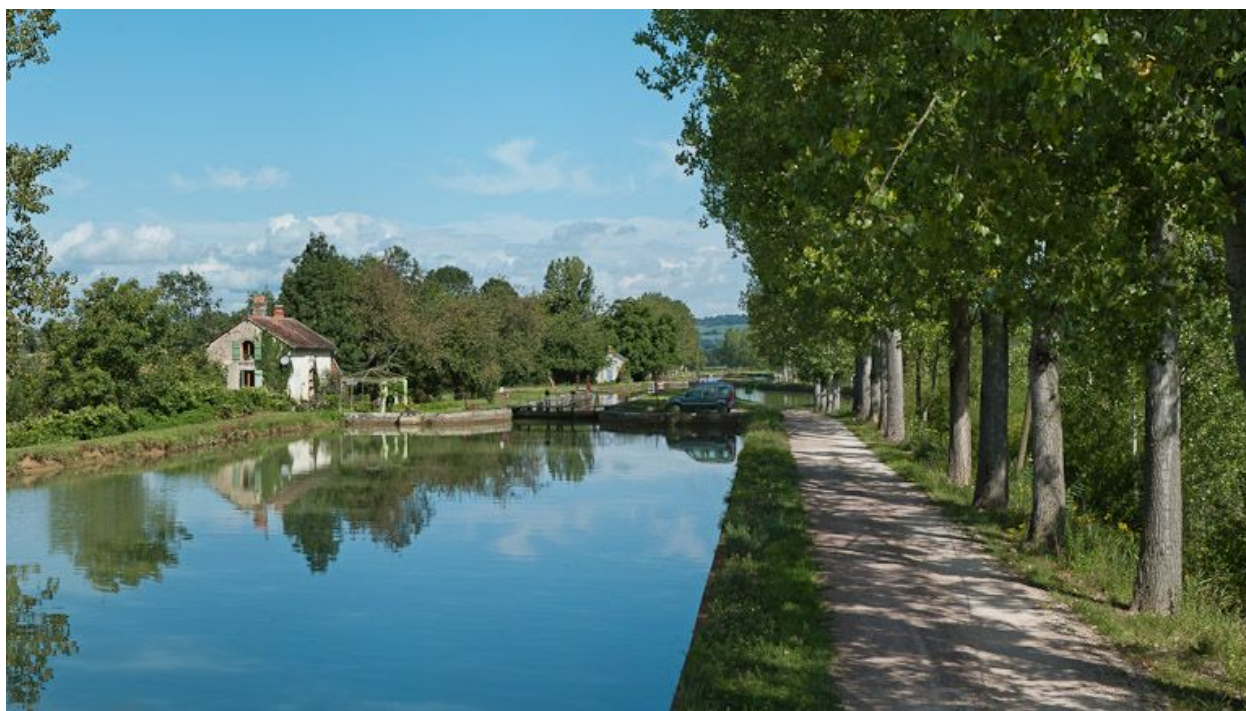
Vue du site d'écluse depuis l'amont.
