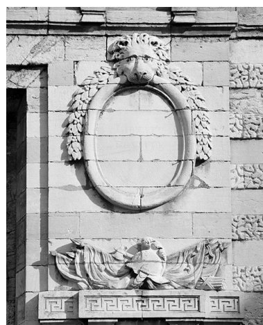
Elévation de la porte Saint- Nicolas, côté ville, détail du décor du piédroit droit. Phot. Jean-Luc Duthu IVR26_19892101040X
