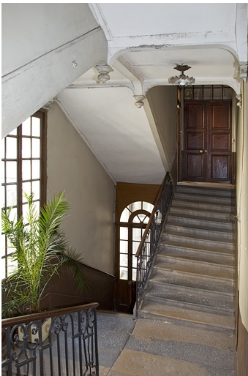
Vue d'ensemble de l'intérieur de l'escalier.
