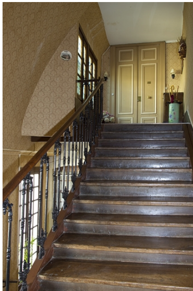
Intérieur de l'escalier : détail d'une volée. Phot. Yves Sancey IVR43_20112500874NUC2A
