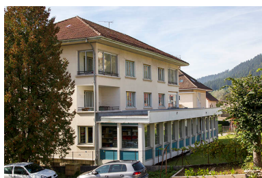
Façade postérieure, vue en enfilade.
