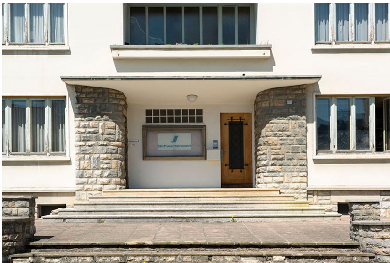
Façade antérieure : entrée.
