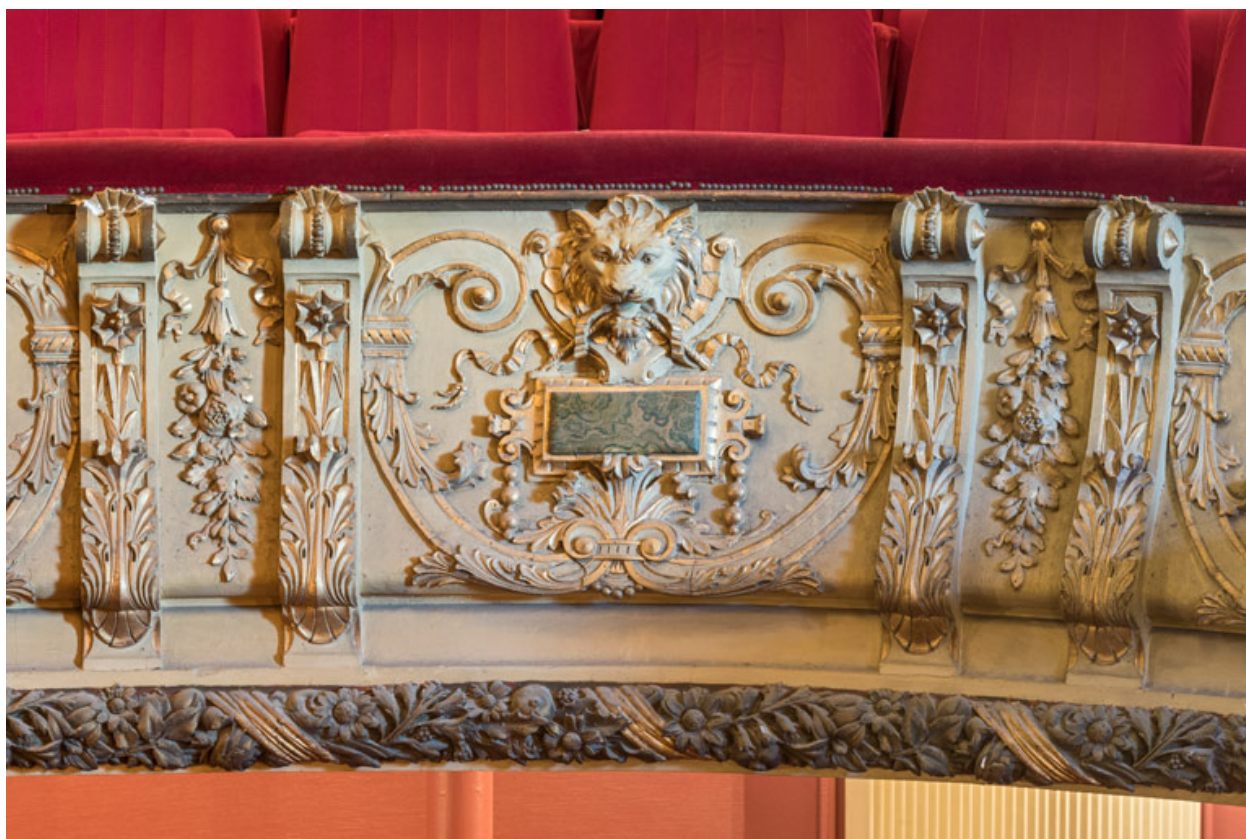
Garde-corps du 1er balcon.
