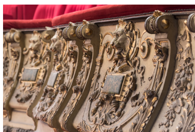
Garde-corps du 1er balcon, vue en enfilade. Phot. Pierre-Marie Barbe-Richaud IVR26_20238900124NUC4A
