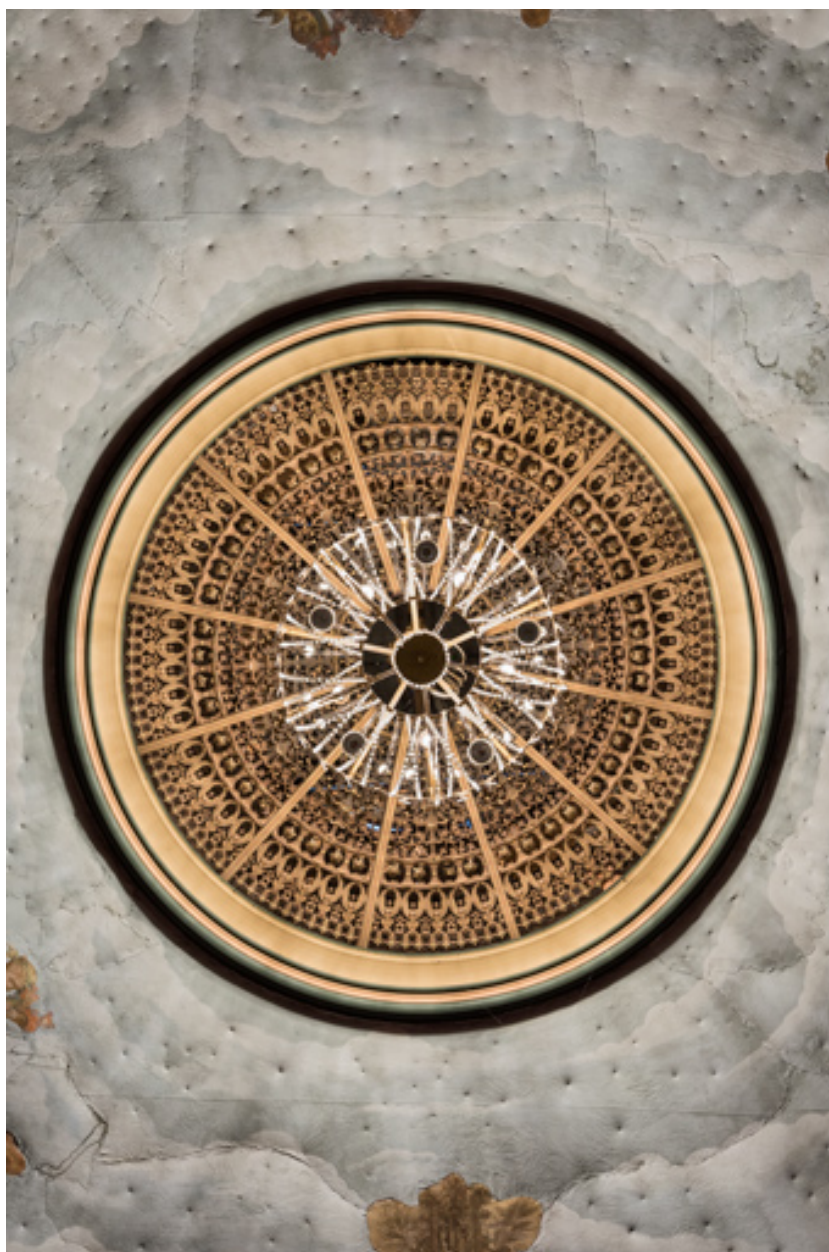
Grille métallique de l'oculus surmontant le lustre.
