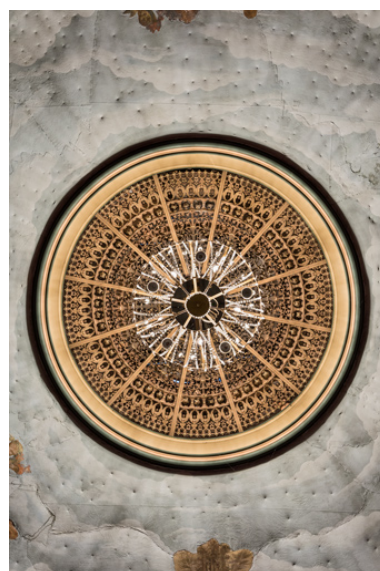
Grille métallique de l'oculus surmontant le lustre. Phot. Pierre-Marie Barbe-Richaud IVR26_20238900127NUC4A
