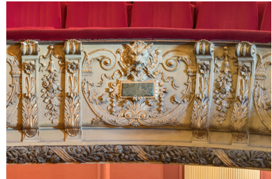
Garde-corps du 1er balcon. Phot. Pierre-Marie Barbe-Richaud IVR26_20238900180NUC4A
