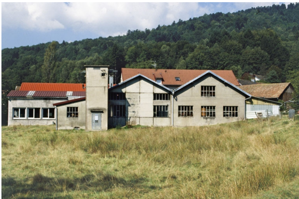
Ateliers de fabrication depuis l'est.
