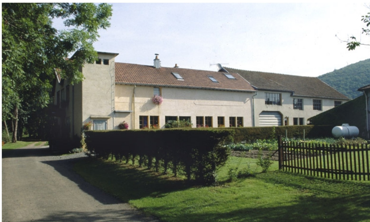
Atelier de fabrication nord depuis la rue.
