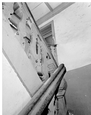
Escalier. Phot. Jérôme Mongreville IVR43_19872500474X
