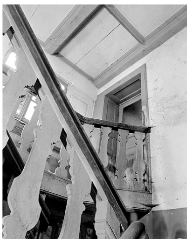
Escalier. Phot. Jérôme Mongreville IVR43_19872500830X
