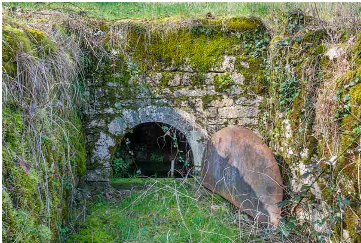
Captage de la source.
