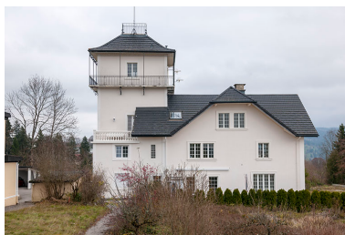
Façade postérieure. Phot. Jérôme Mongreville IVR43_20152502286NUC4A
