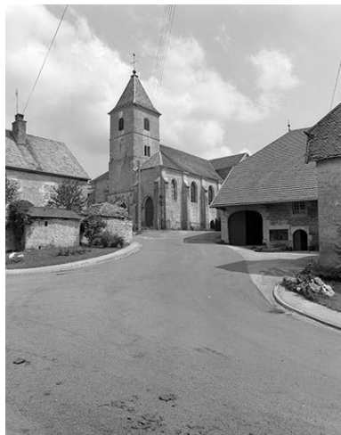
Vue générale. Phot. Yves Sancey IVR43_19812500224X
