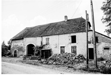
Façade antérieure. Phot. Bernard Pontefract IVR43_19753900447Z
