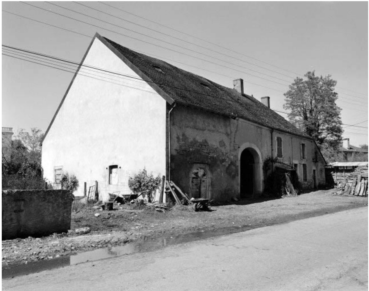
Façades antérieure et latérale gauche.
