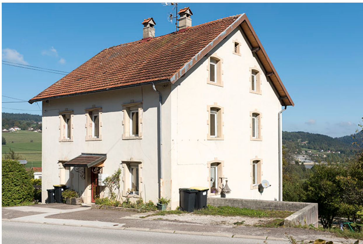
Façades antérieure et latérale droite.
