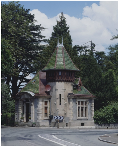
La conciergerie depuis le sud-ouest.
