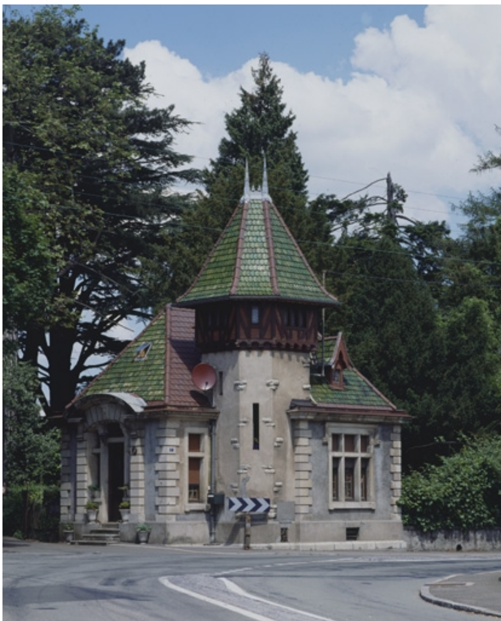
La conciergerie depuis le sud-ouest.
