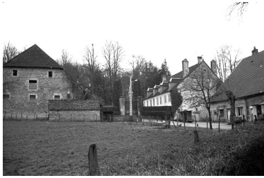
Vue générale. Phot. Guy Forestier IVR43_19743900415Z
