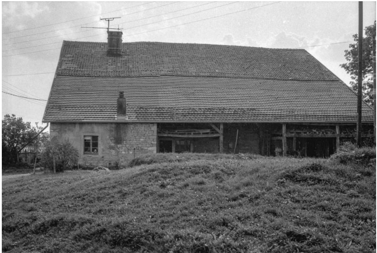
Façade latérale droite.
