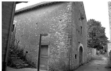
Façades antérieure et latérale droite.
