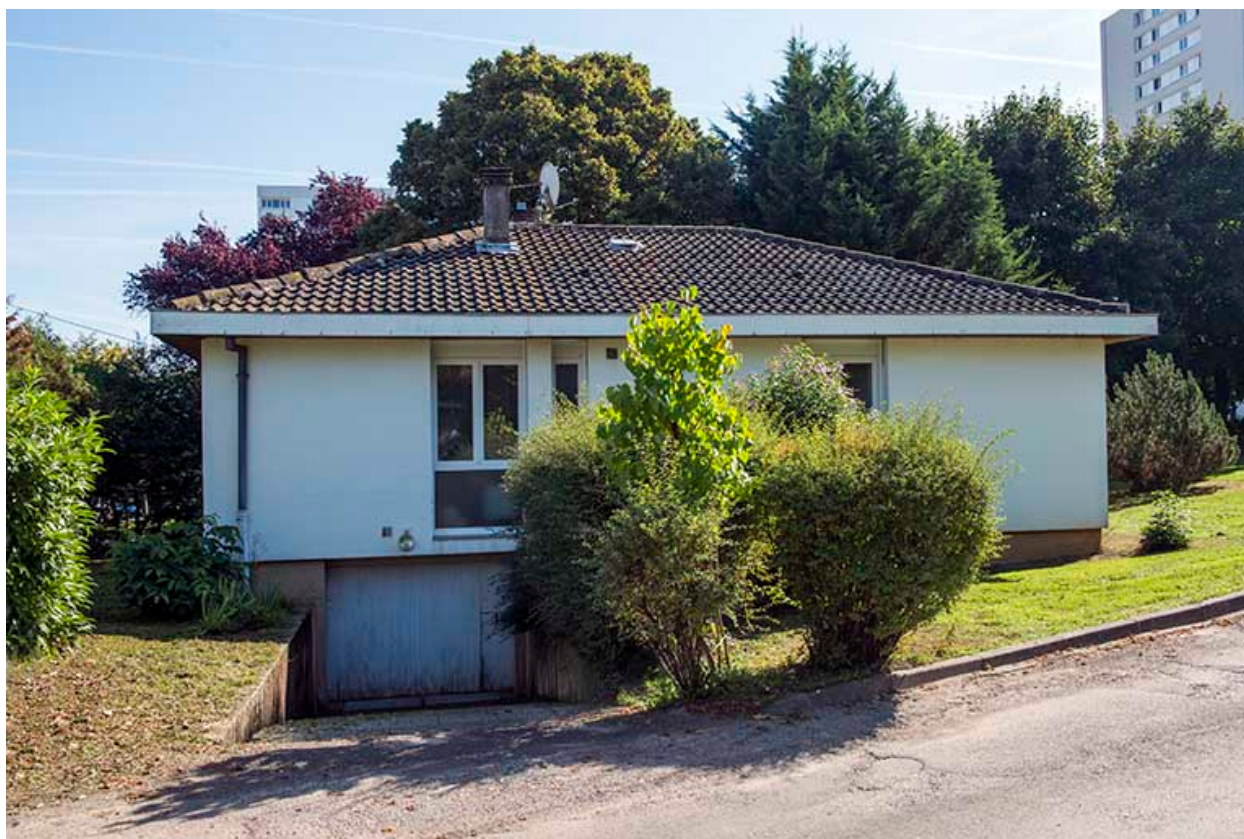
Façade ouest du pavillon logement.
