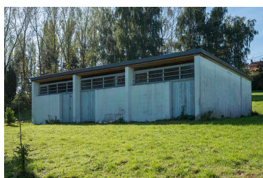
Angle nord-ouest et façade nord-est du dépôt.
