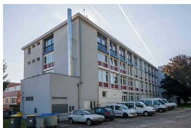
Chaufferie à l'angle nord-ouest de l'externat. Phot. Mary Ruffinoni IVR43_20137000725NUC4A
