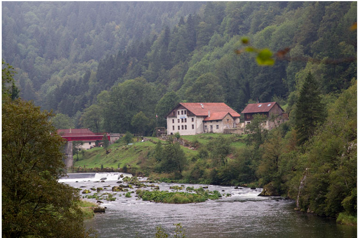
Vue d'ensemble du site depuis l'aval.
