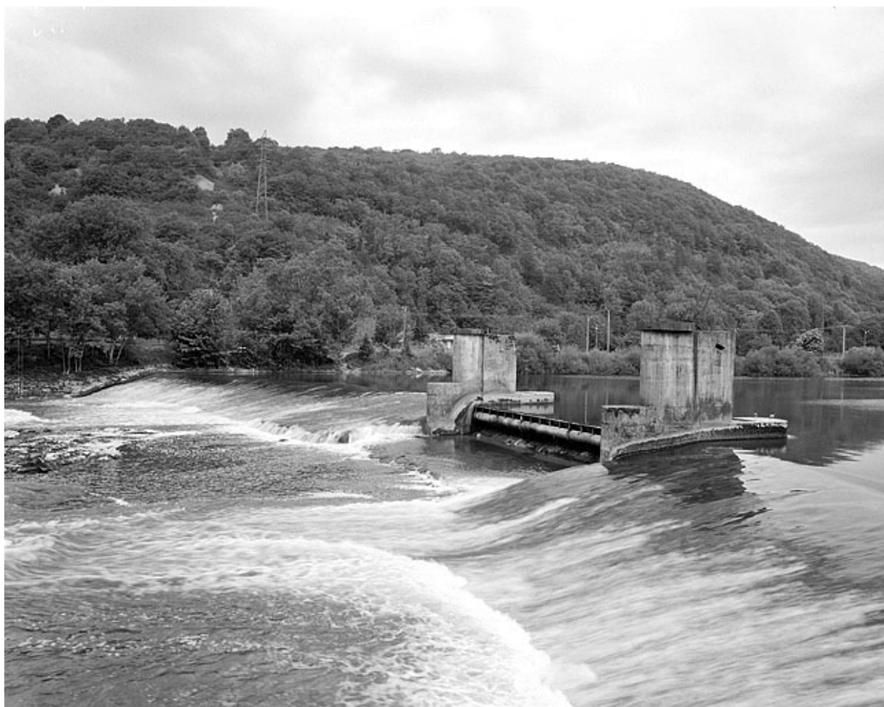
Vue d'ensemble depuis l'écluse, rive gauche.
