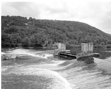
Vue d'ensemble depuis l'écluse, rive gauche. Phot. Jérôme Mongreville IVR43_20032500218X
