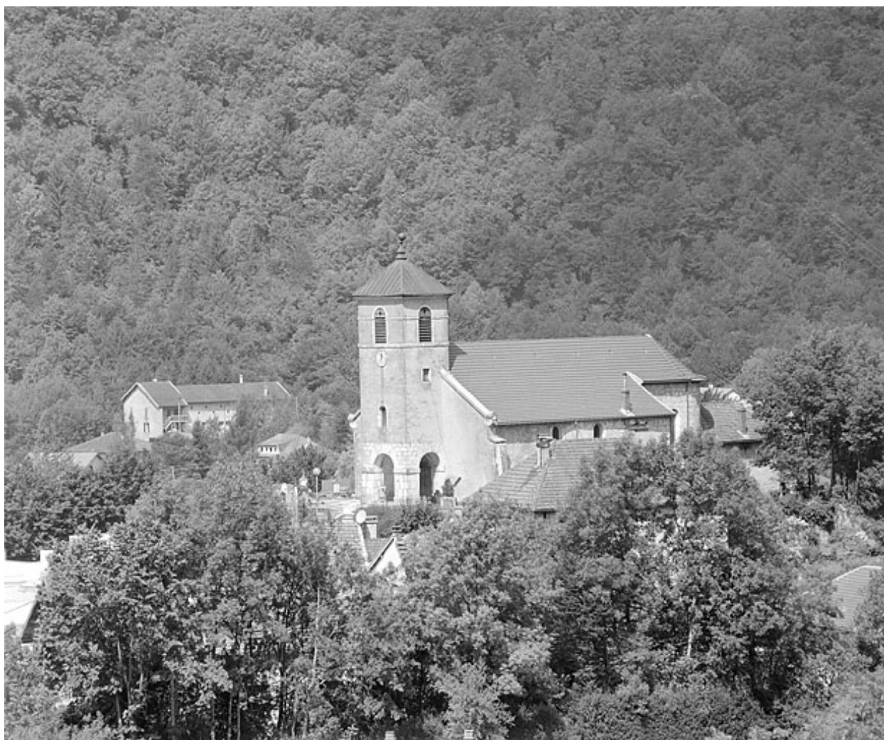
Vue de situation depuis le sud-ouest.
