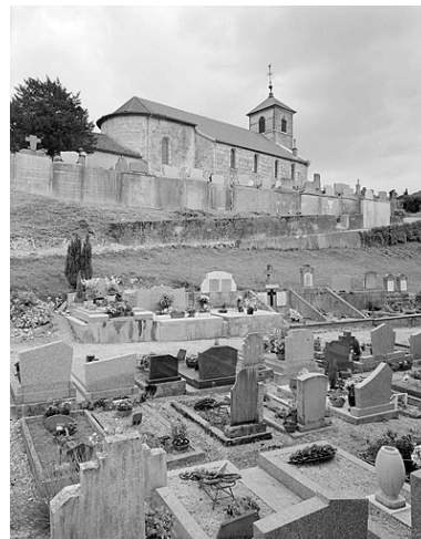
Face nord et abside vues depuis le cimetière. Phot. Yves Sancey IVR43_19963900807V
