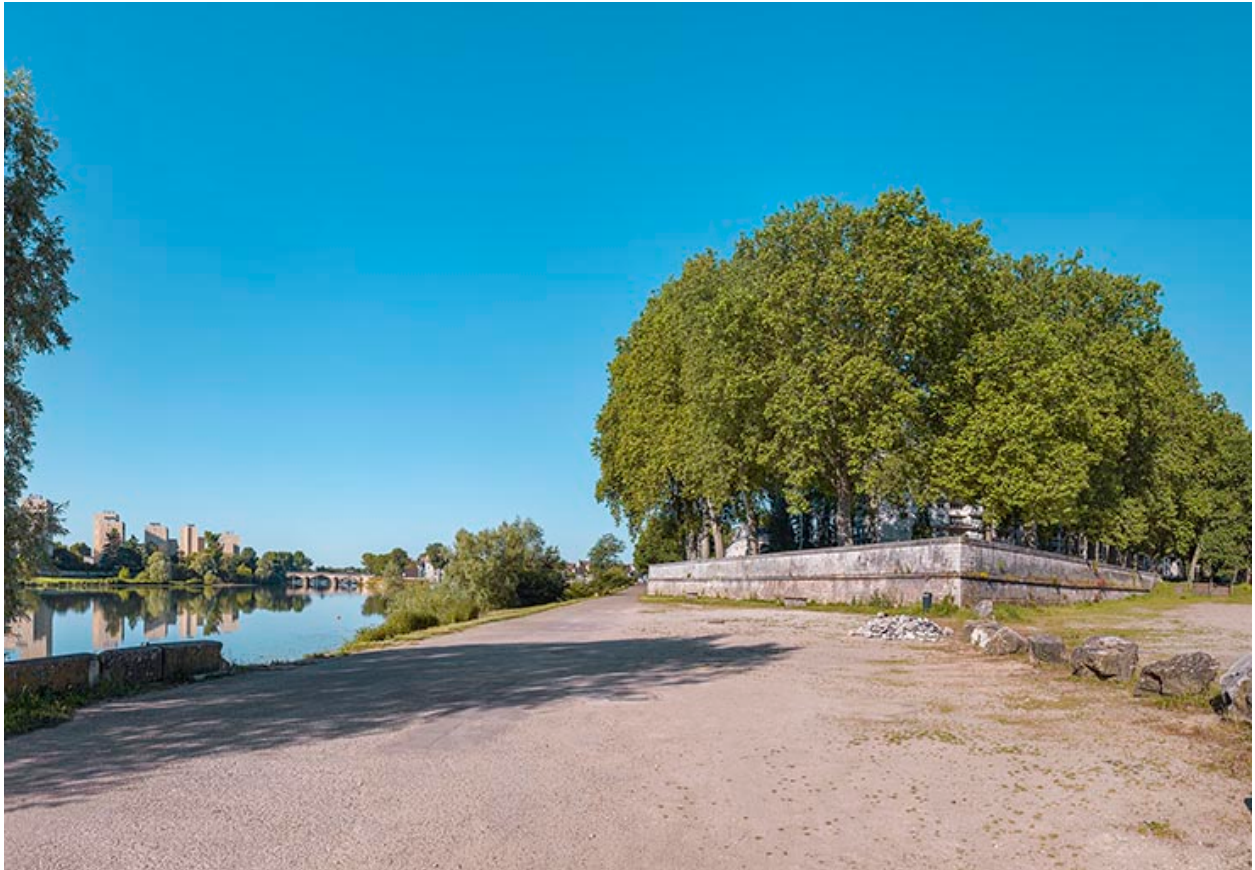
Le bastion, vue depuis l'amont.
