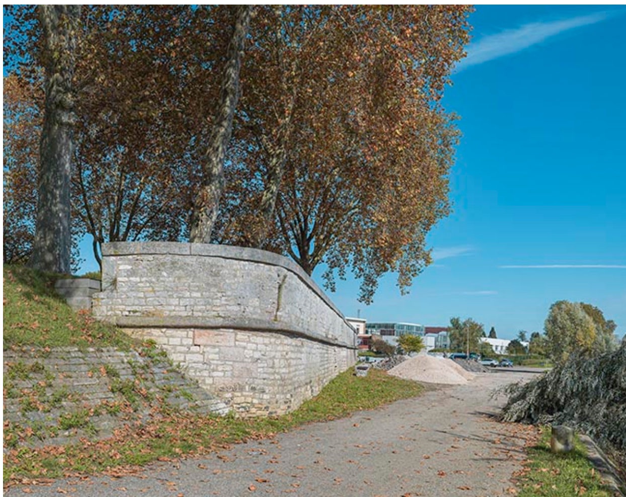
Le bastion Sainte-Marie, vue depuis l'aval.
