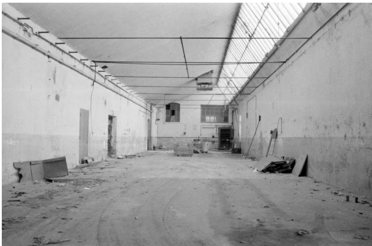
Atelier des cannetières (3). Au fond à gauche : ancienne entrée principale de l'usine, en avant du bobinage.
