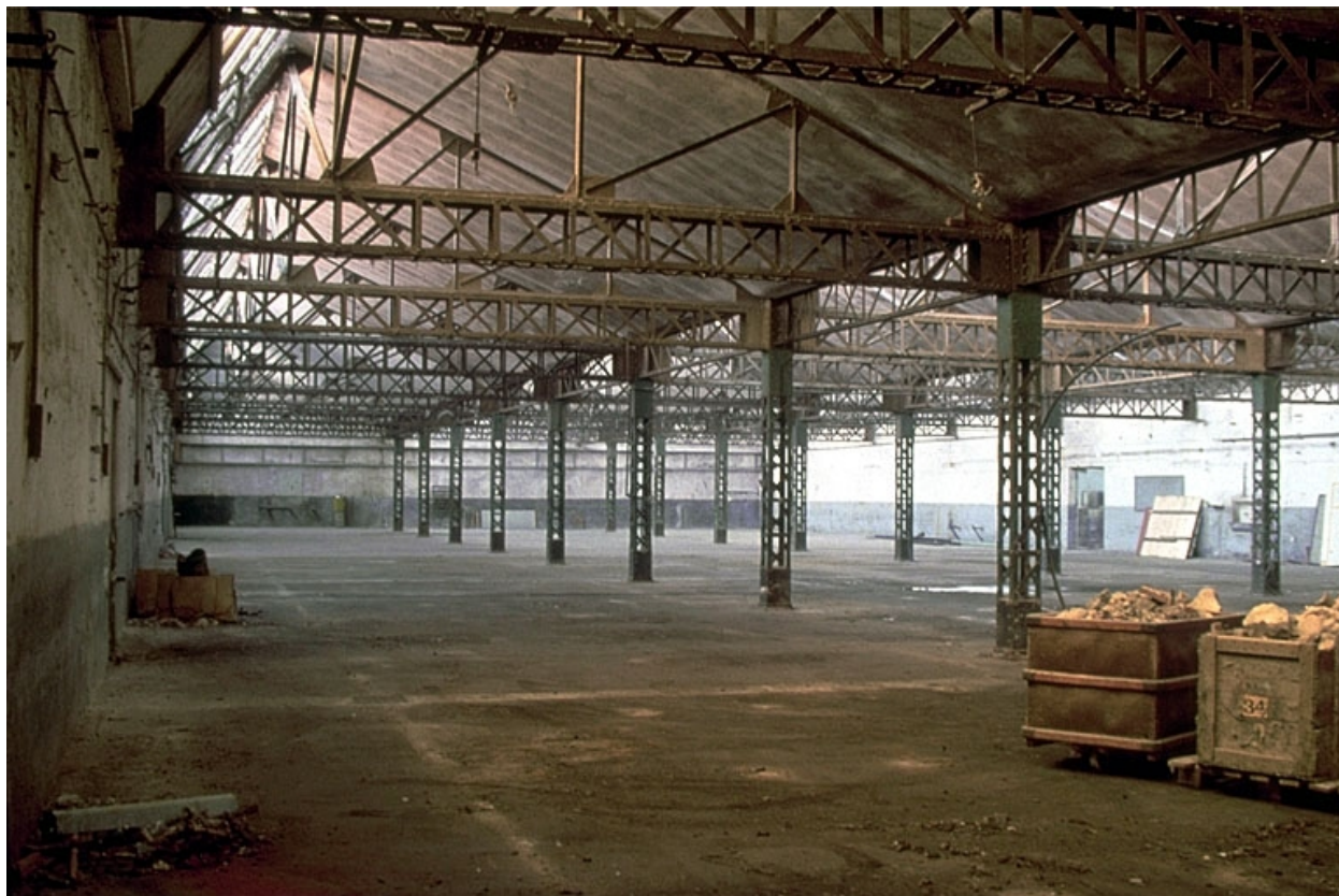
Atelier de fabrication (1), vu depuis l'angle nord-ouest.
