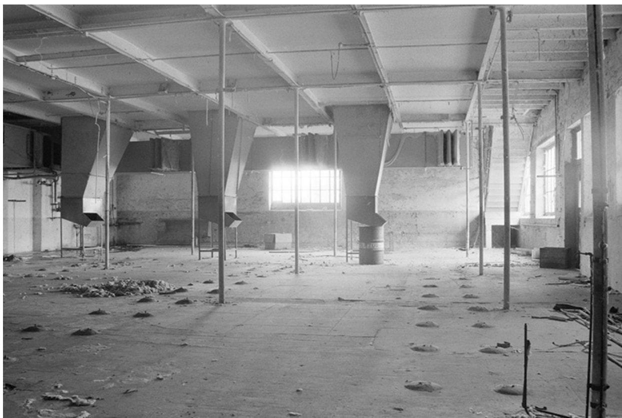
Atelier de bobinage (7). L'alimentation des bobinoirs en cannettes de filature s'effectuait depuis l'étage de comble par les trois conduits.
