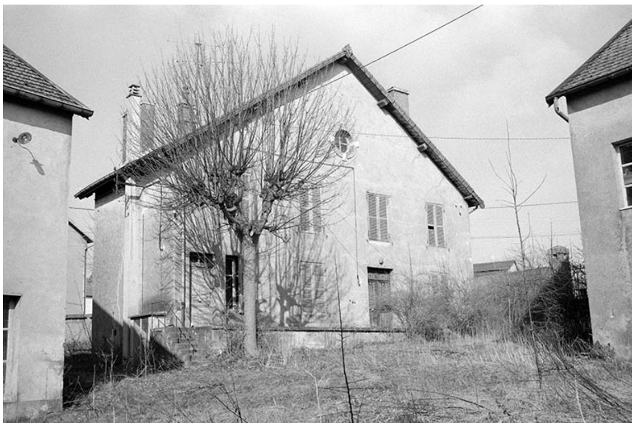
Façade antérieure du bureau vue de l'est.
