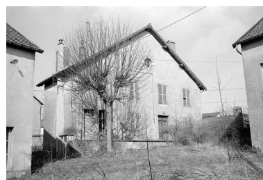
Façade antérieure du bureau vue de l'est. Phot. Laurent Poupard IVR43_19883900156Z
