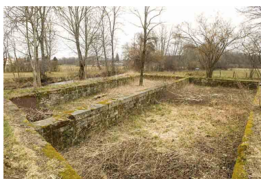
Fosses à pulpe. Phot. Jérôme Mongreville IVR43_20097000251NUC2A
