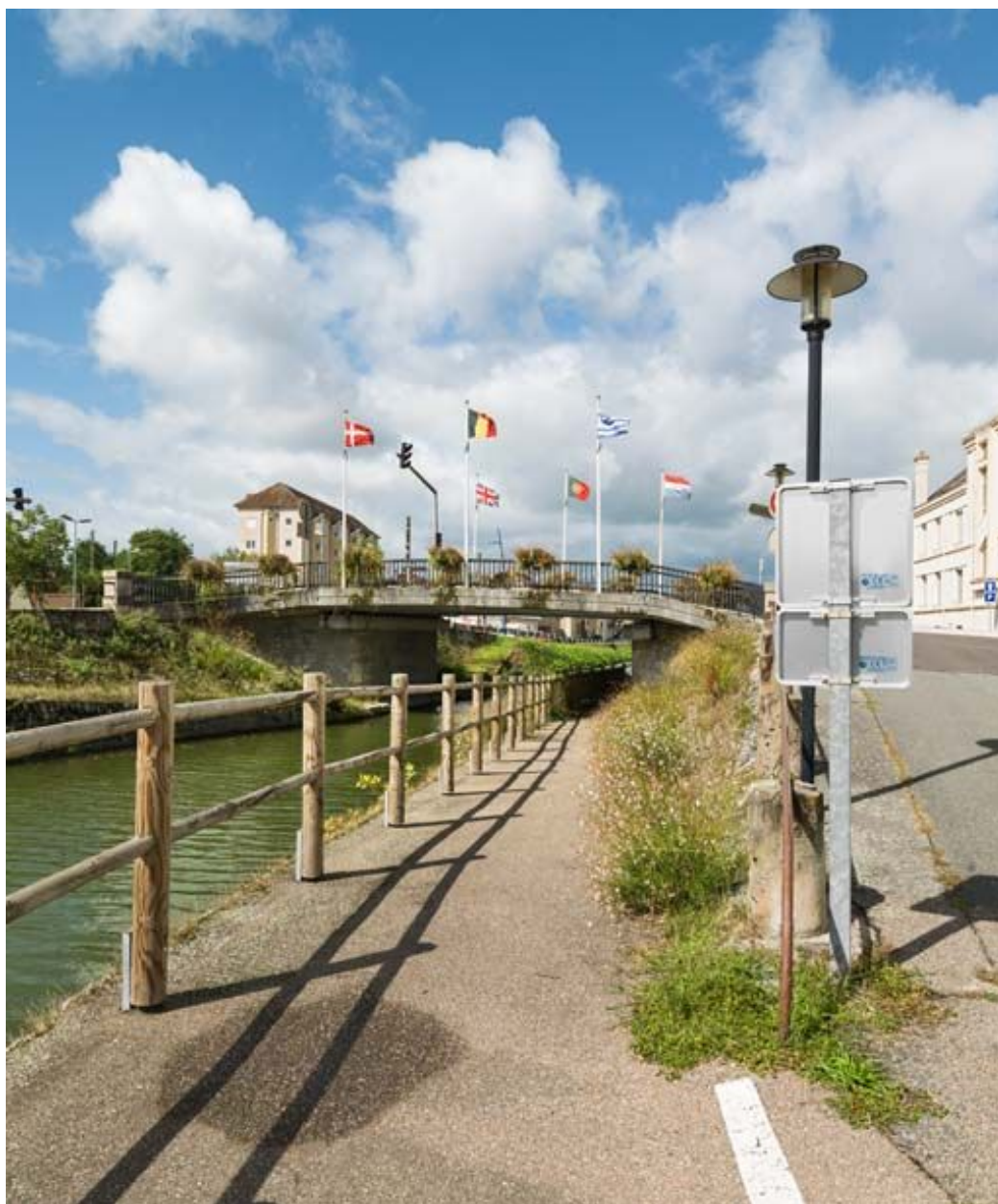
Vue d'ensemble du pont.
