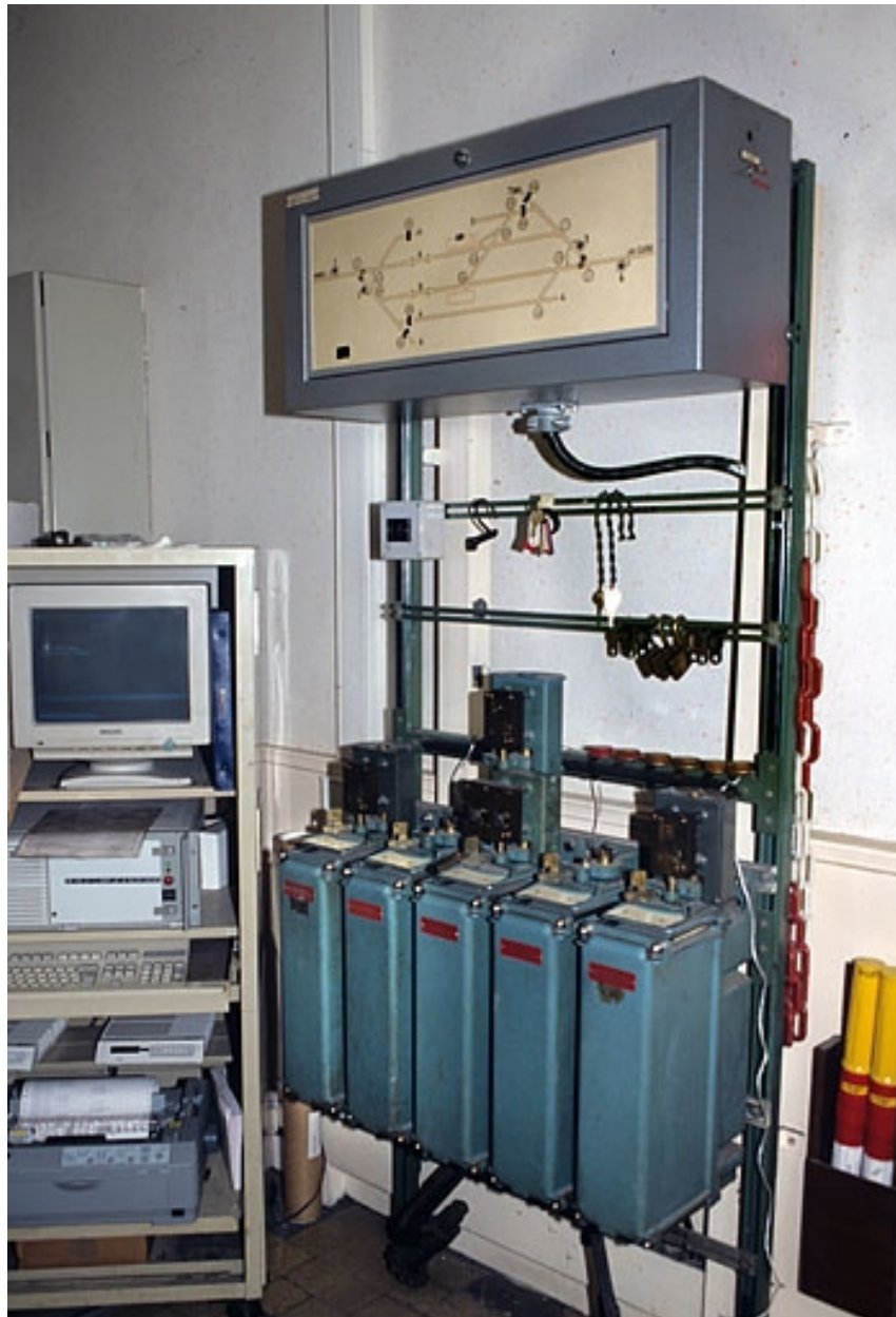
Vue d'ensemble, de trois quarts droite. Le tableau de contrôle optique surmonte les commutateurs. A gauche, ordinateur du système CAPI (cantonnement assisté par informatique).
