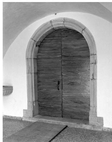
Le portail d'entrée de la nef. Phot. Yves Sancey IVR43_19943900643X
