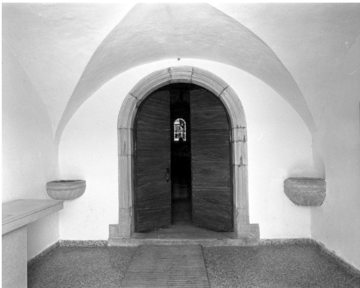
Le vestibule sous la tour-clocher.
