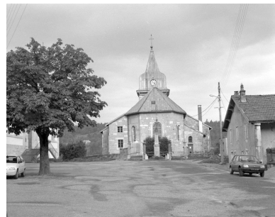
Extérieur : l'abside. Phot. Yves Sancey IVR43_19943900997X
