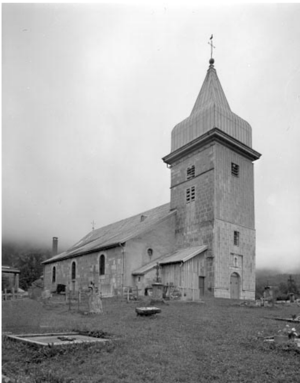
Extérieur : façade occidentale et face nord.
