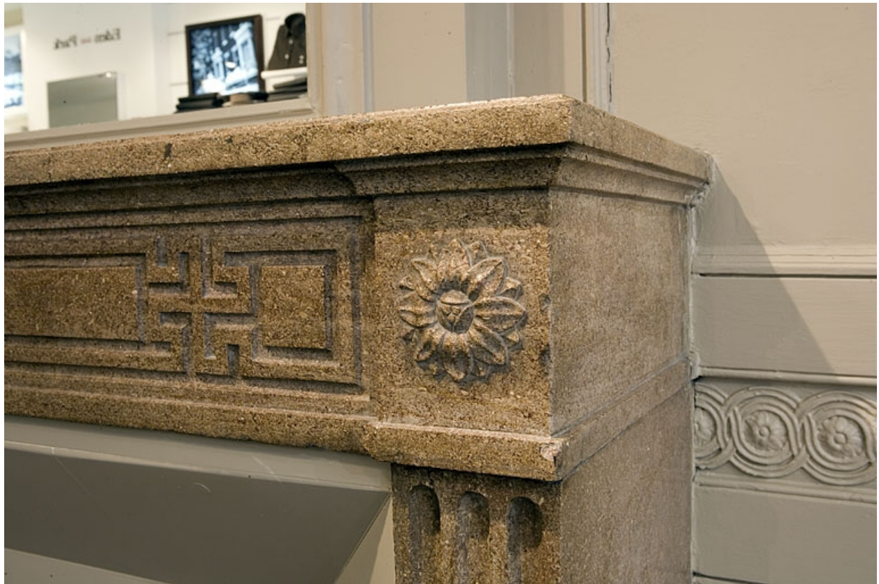
Détail d'une rosace couonnant l'un des piedroits de la cheminée située au premier étage.
