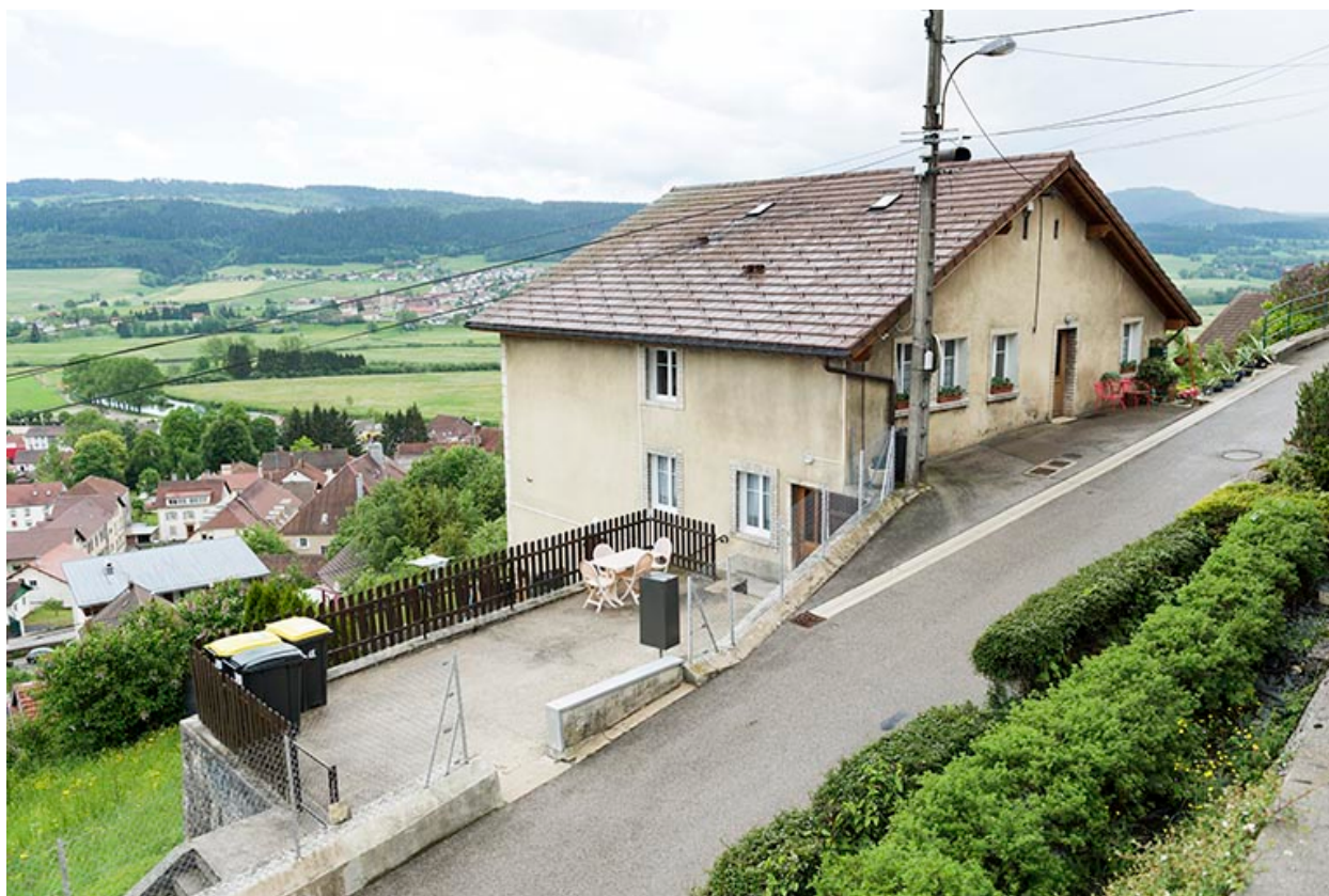
Façades latérale gauche et antérieure.
