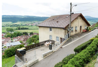
Façades latérale gauche et antérieure. Phot. Sonia Dourlot IVR43_20182500698NUC4A
