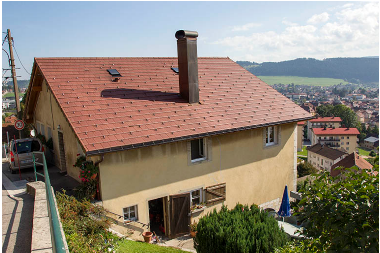
Façades latérale droite et antérieure.
