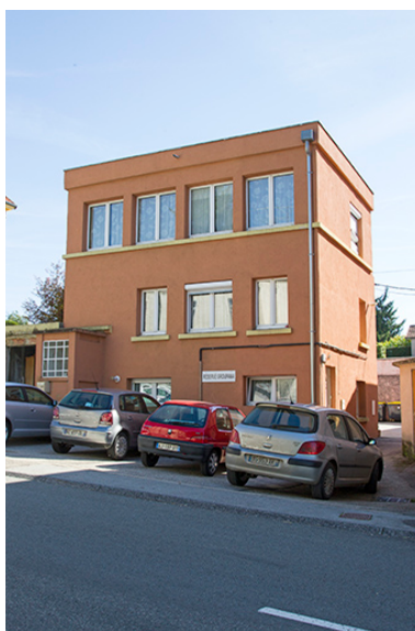
Atelier, de trois quarts droite. Phot. Yves Sancey IVR43_20132502417NUC2A
