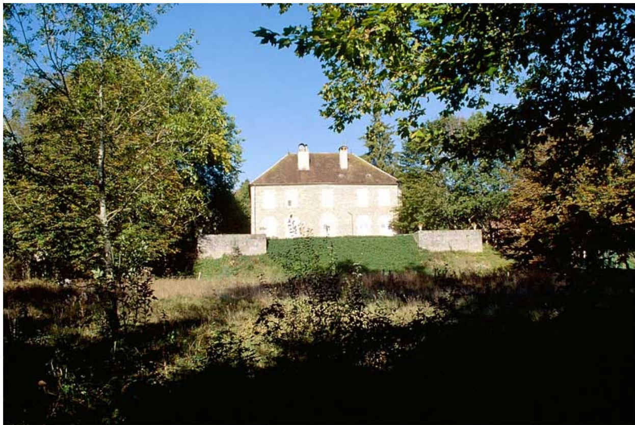
Façade postérieure du logement patronal.
