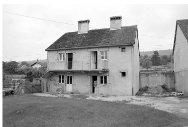
Façade sur cour d'un logement ouvrier. Phot. Jack Dumont IVR43_19803900340Z
