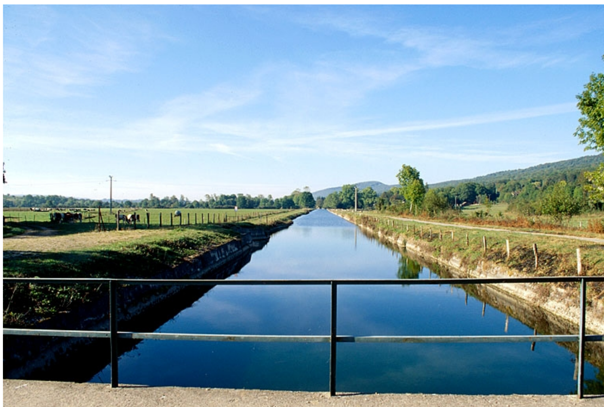
Le canal d'amenée depuis la prise d'eau.
