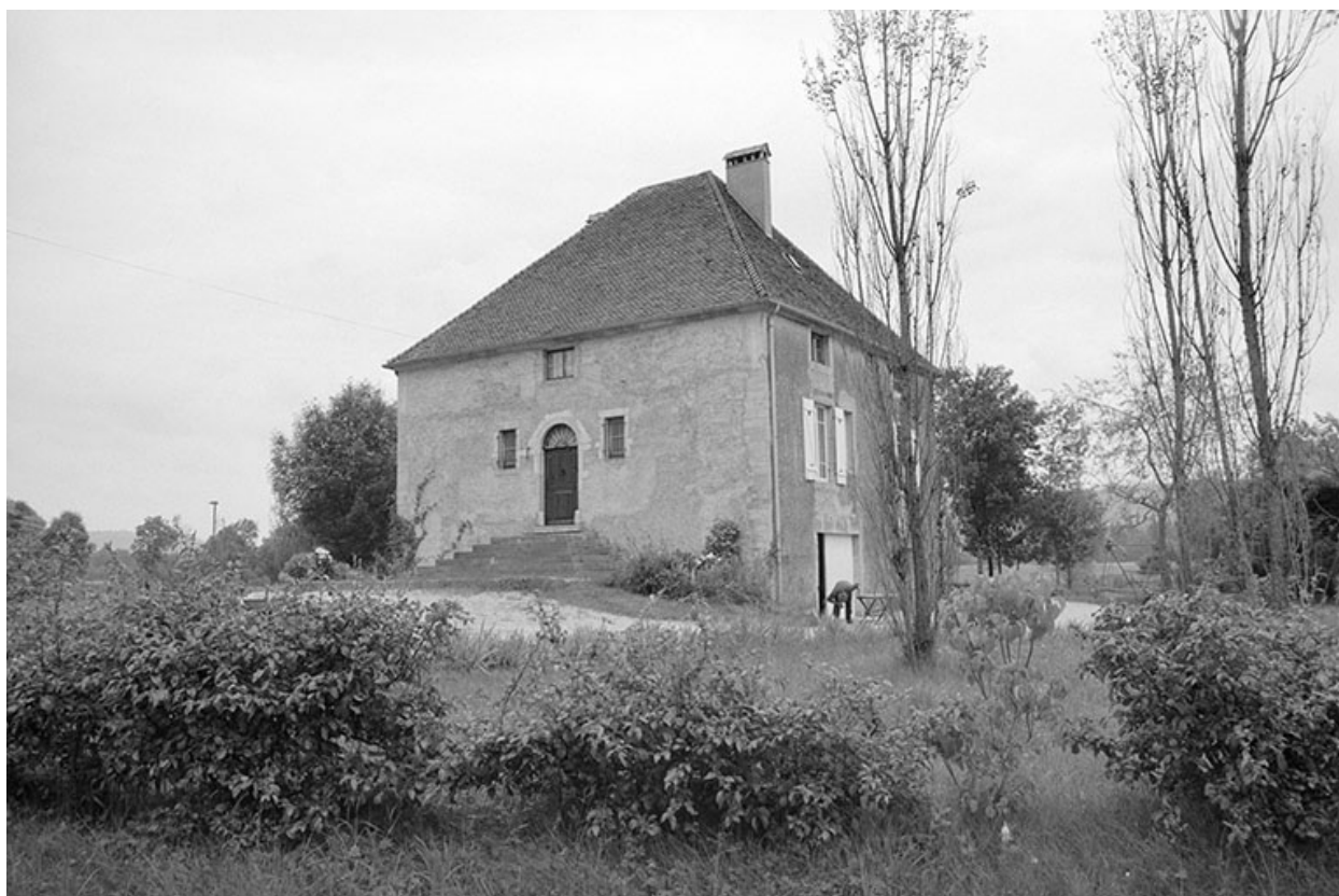
Logement d'ouvriers et bureau.
