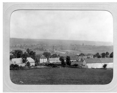
Vue d'ensemble à la fin du 19e siècle. Phot. Yves Sancey, Autr. NEPASUTILISERDe Jongh Frères (photographe) IVR43_19883900490V
