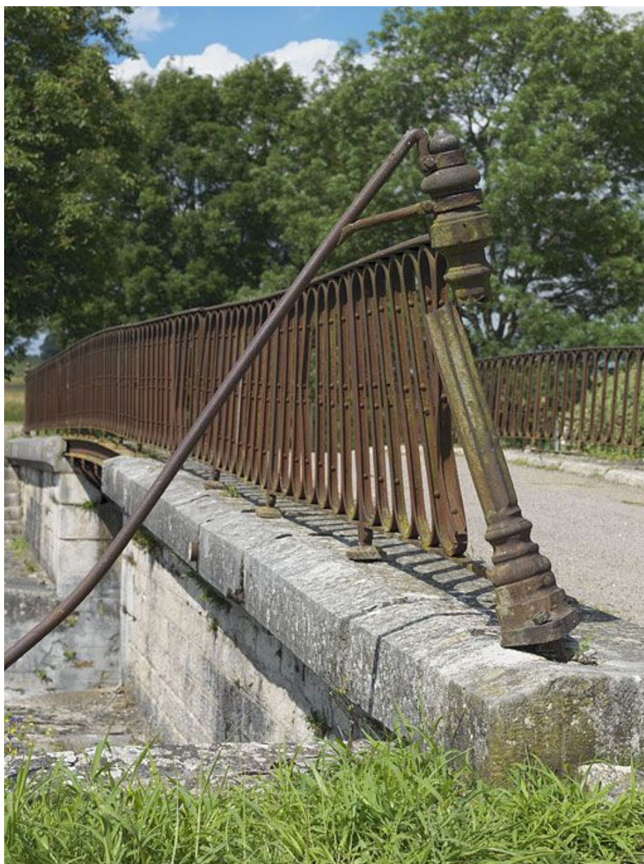
Pont sur écluse : détail du garde-corps.
