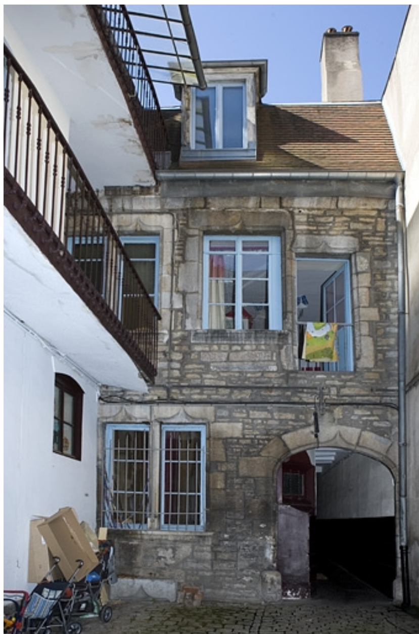
Façade postérieure du logis principal, de face.
