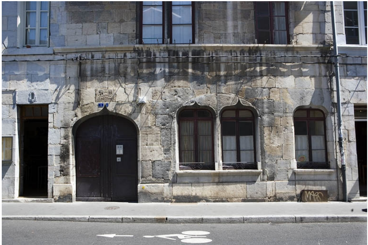
Détail du rez-de-chaussée sur rue.
