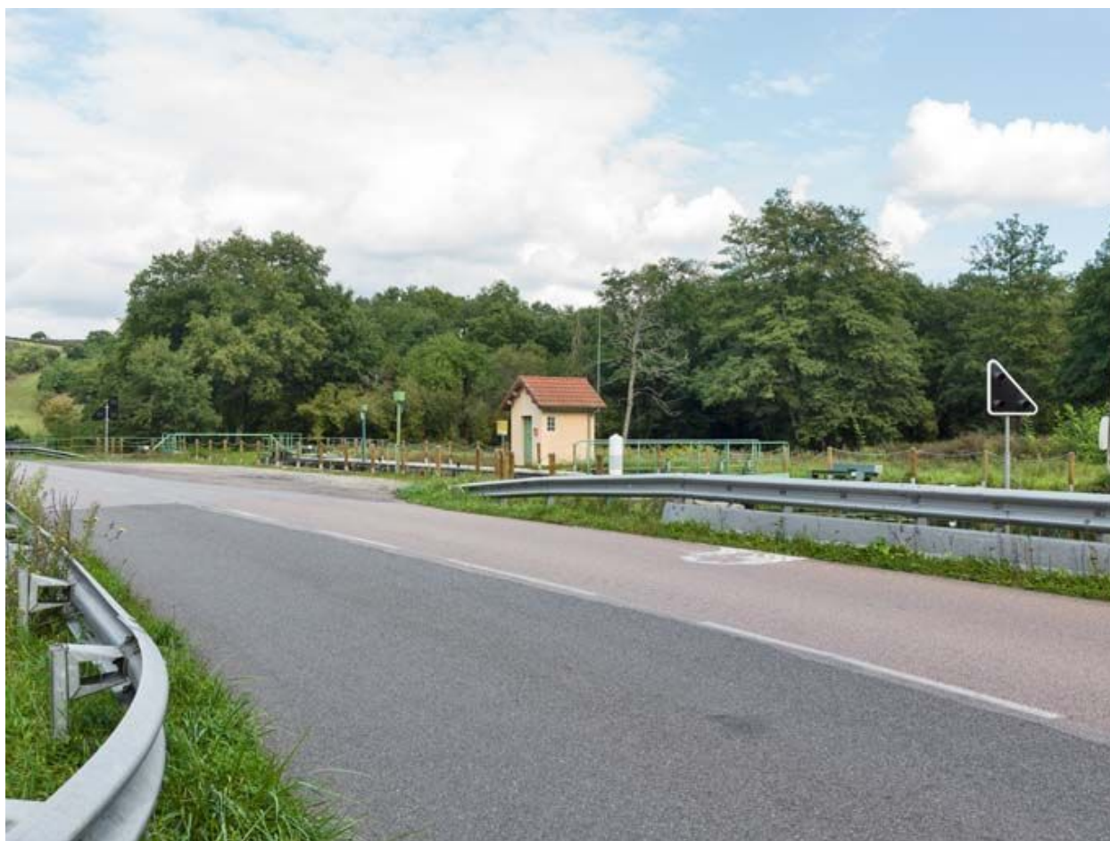
Vue d'ensemble du site d'écluse.
