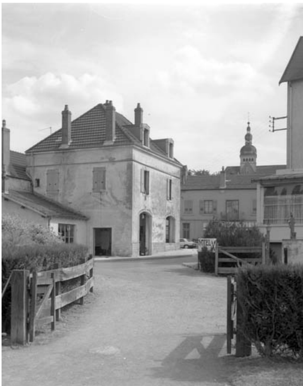
Façades postérieure et latérale gauche.
