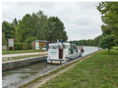
Vue du site d'écluse. Phot. Pierre-Marie Barbe-Richaud IVR26_20178900051NUC2A
