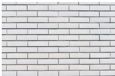
Détail du mur occidental de la chaufferie. Phot. Mary Ruffinoni IVR43_20149000093NUC4A
