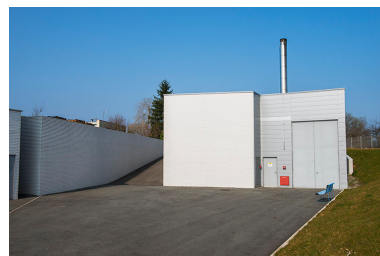
Façade postérieure sud de la chaufferie. Phot. Mary Ruffinoni IVR43_20149000096NUC4A
