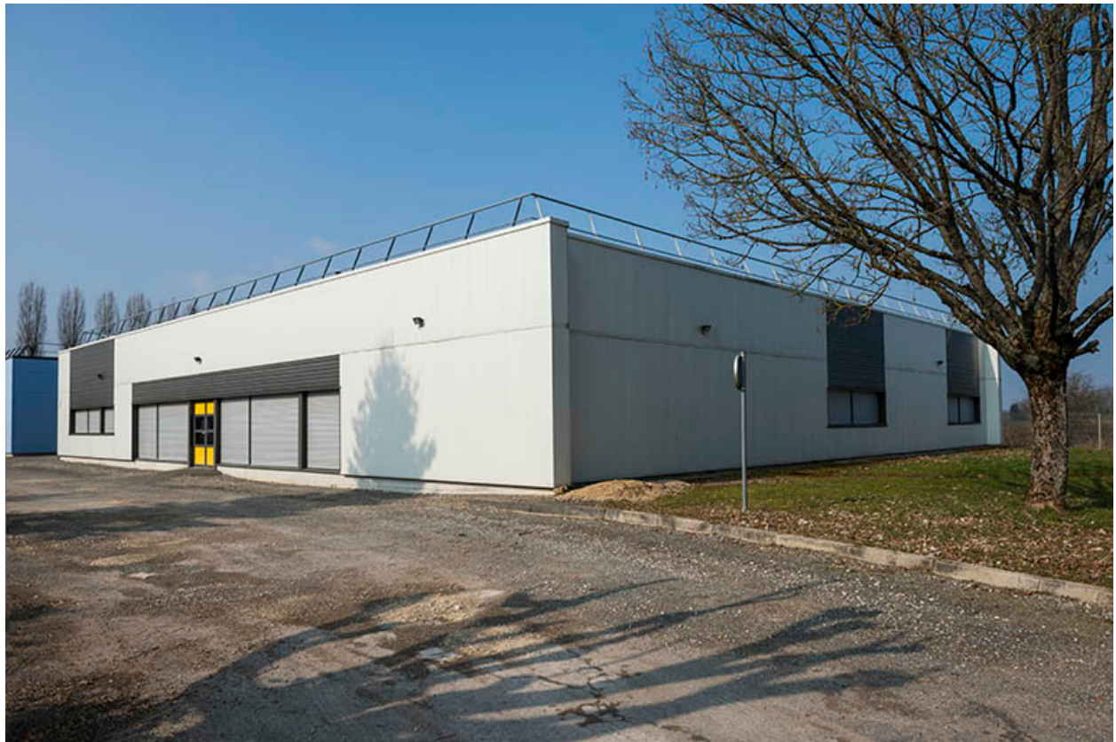
Angle sud-est des ateliers.
