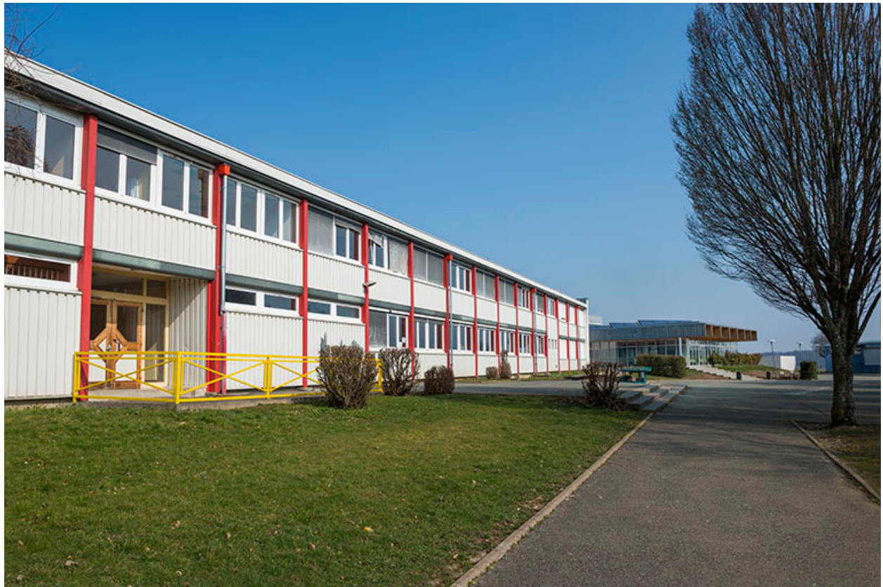
Façade sud de l'externat sud.
