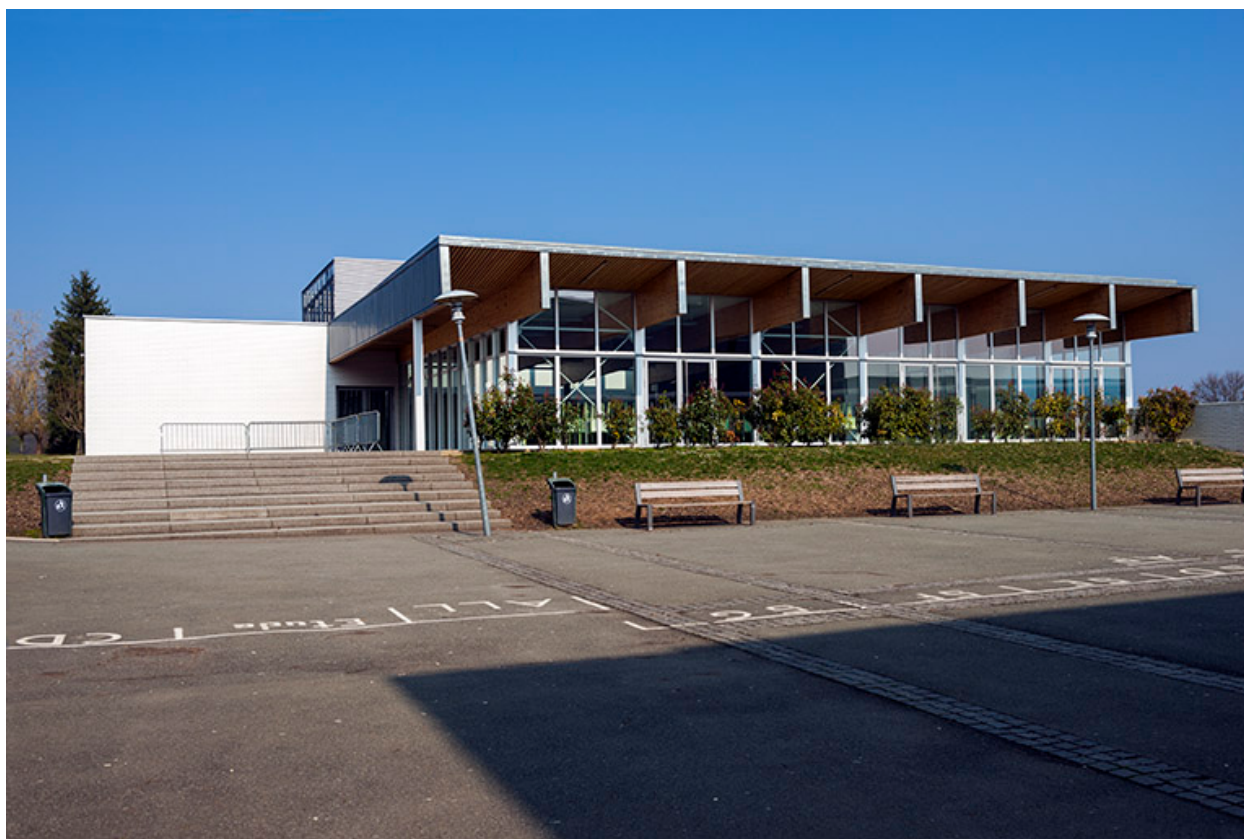
Façade sud de la cantine.
