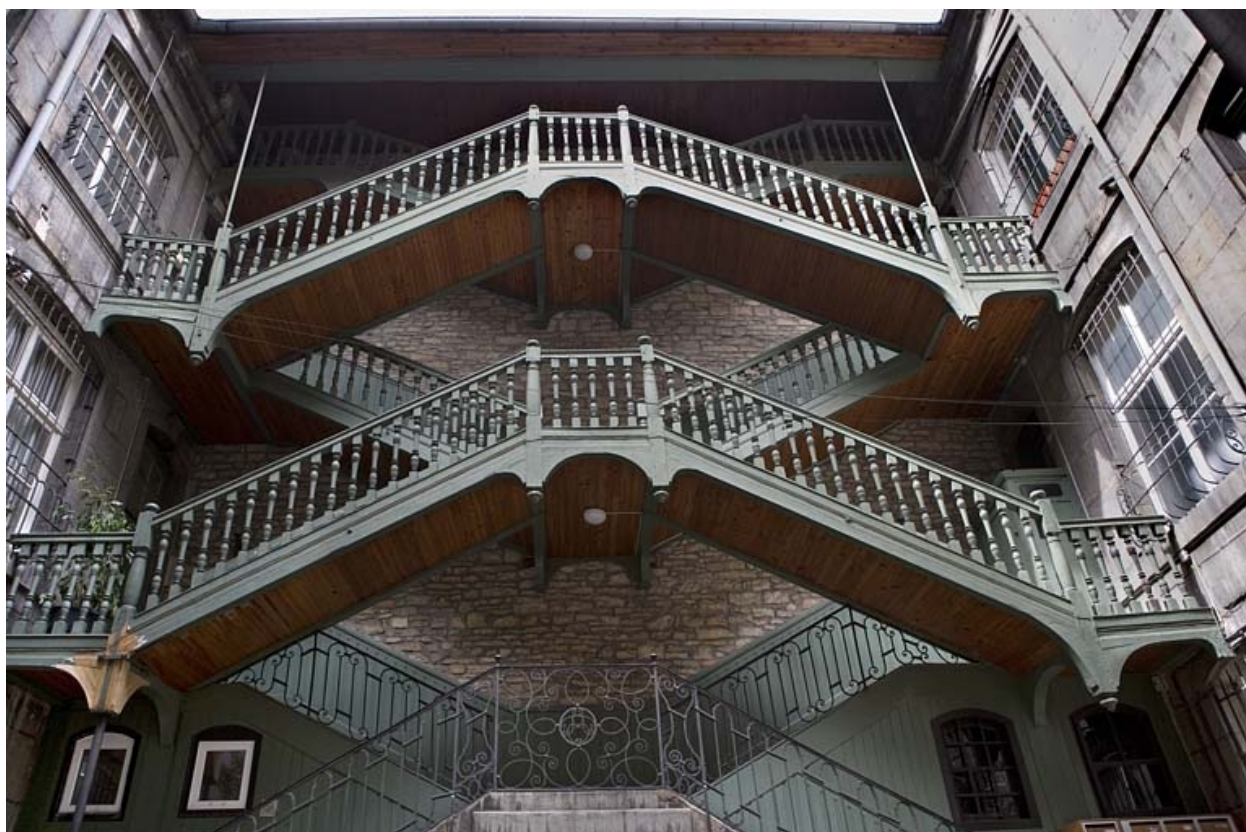
Escalier à cage ouverte à droite de la première cour : vue d'ensemble, de face, des volées suspendues en charpente.
