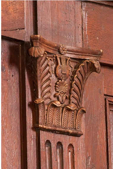
Détail d'un chapiteau. Phot. Pierre-Marie Barbe-Richaud IVR26_20162100209NUC2A
