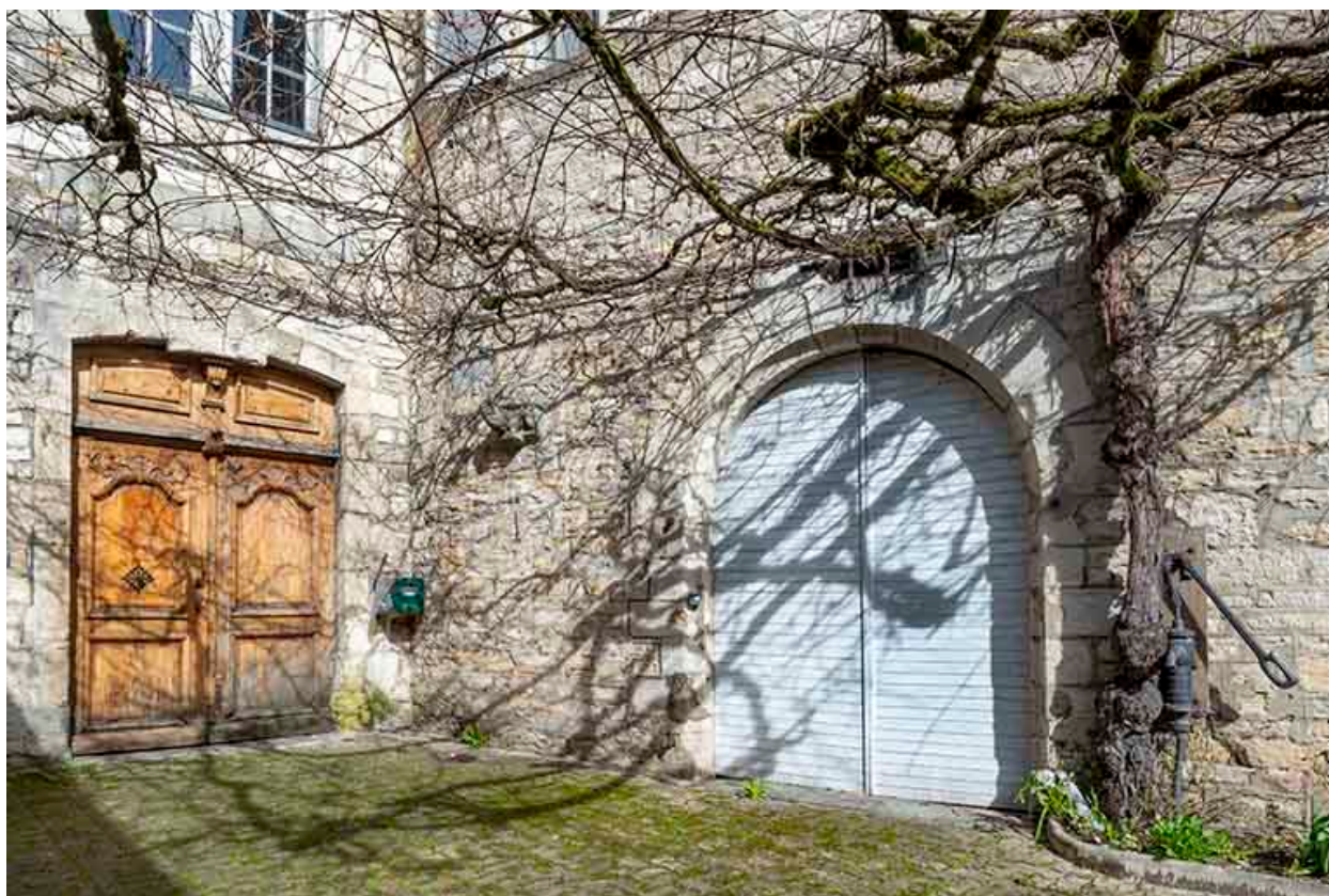
Portes sur la cour.
