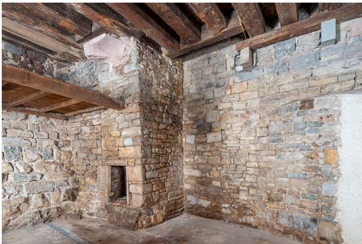
Cave ouest. Maçonneries à l'angle nord-est.
