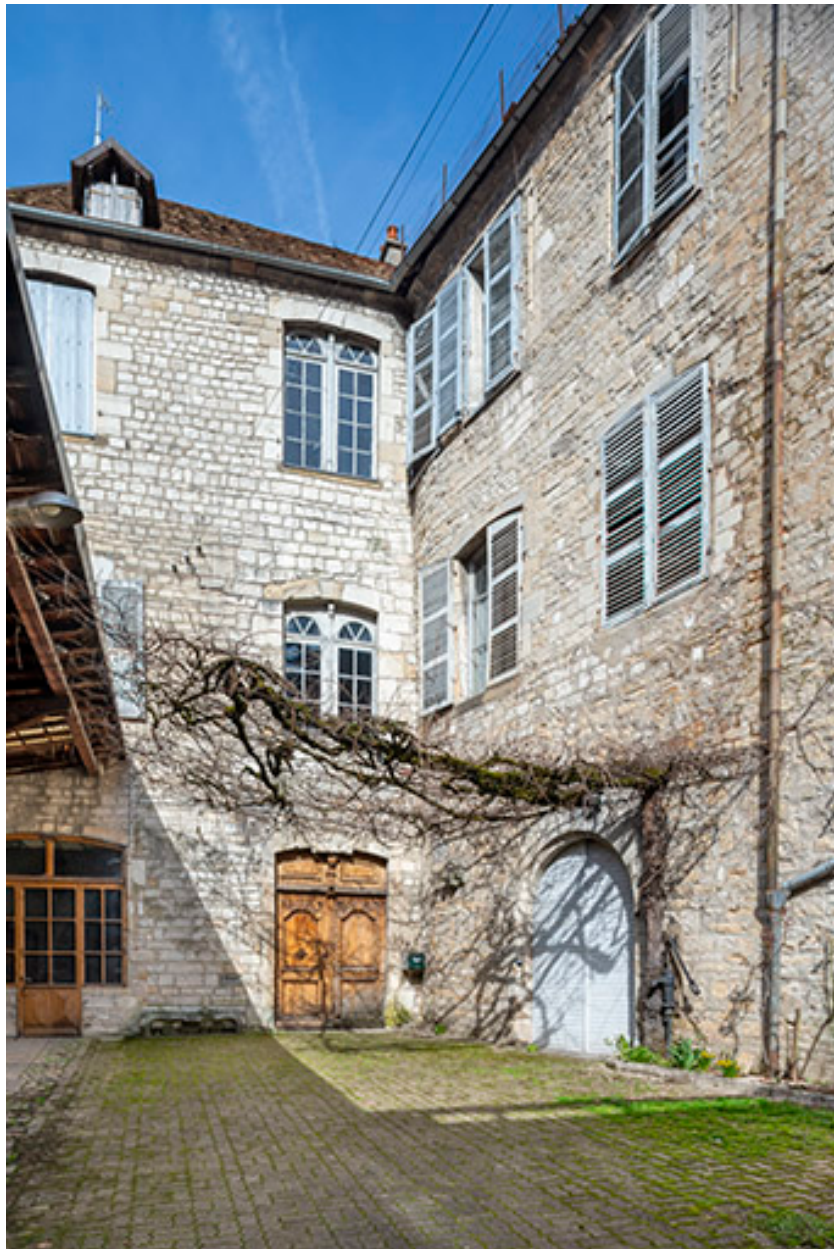
Façades est et sud depuis la cour.
