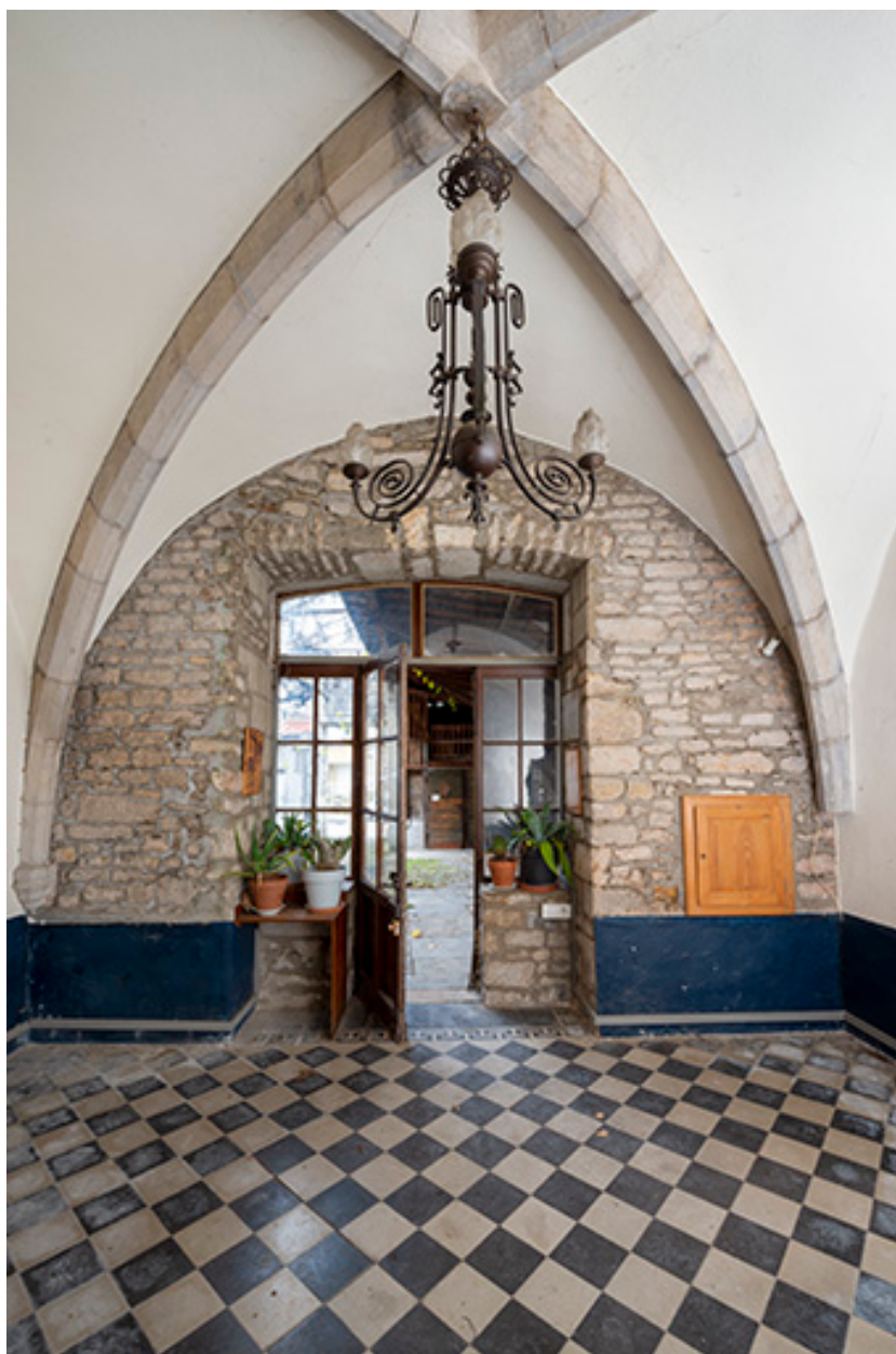
Pièce voûtée (rez-de-chaussée de la tour).
