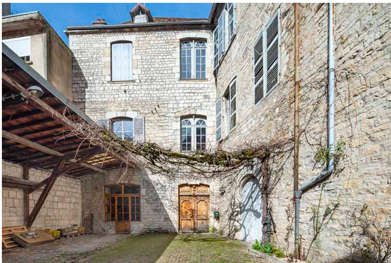
La cour vue depuis le nord-est.
