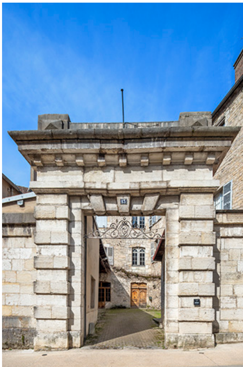
Porte monumentale de la cour.
