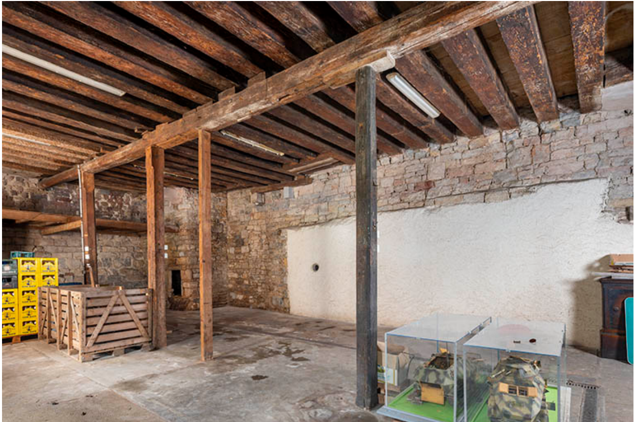
Cave ouest. Vue partielle de trois quarts.
