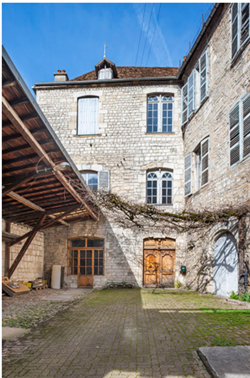
Vue depuis la porte de la cour.
