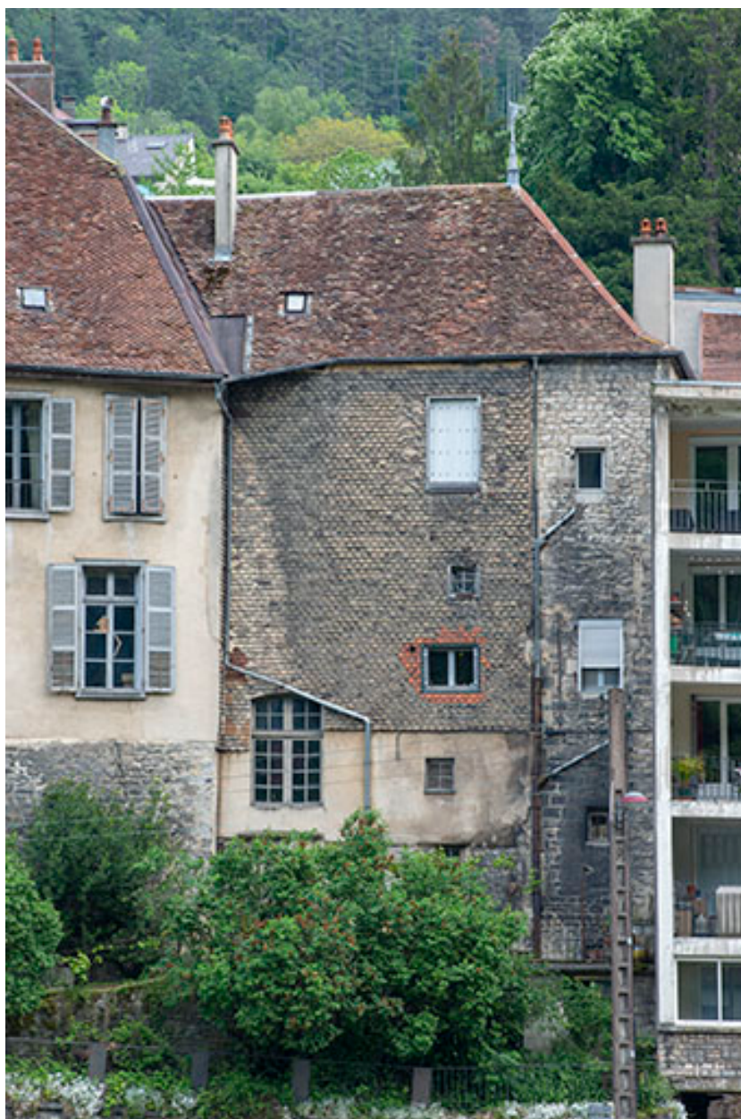
Extrémité sud de la façade occidentale.
