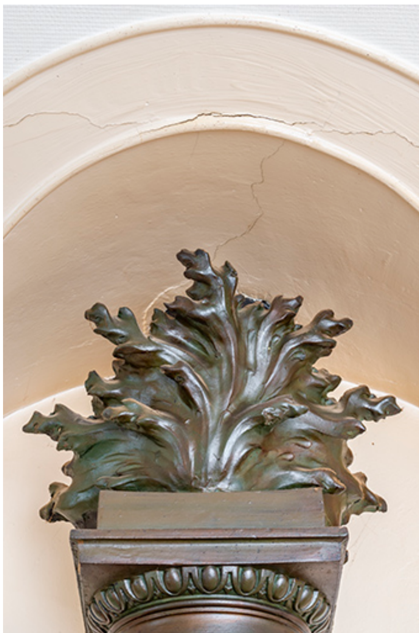
Cheminée. Couronnement du conduit d'évacuation (grès flammé).
