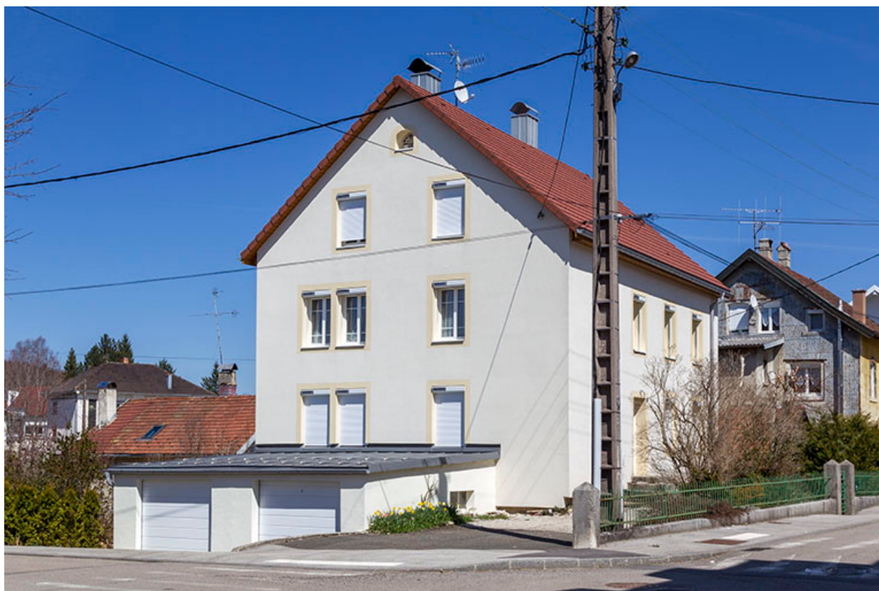
Façades antérieure et latérale gauche.
