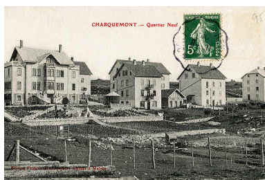
Charquemont - Quartier Neuf, entre 1903 et 1918 ? La maison est l'avant-dernière à droite.
