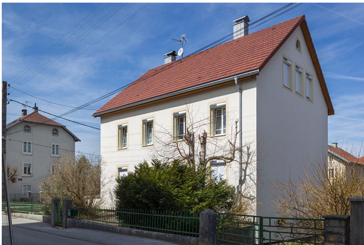
Façades antérieure et latérale droite.
