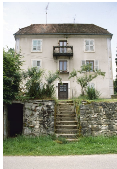
Façade antérieure du logement patronal.
