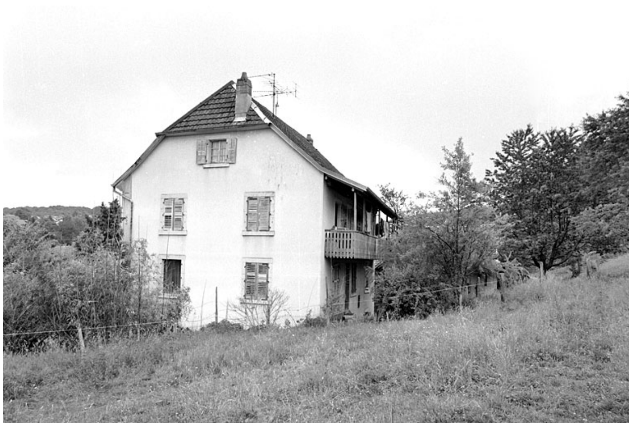
Logement patronal depuis l'ouest.
