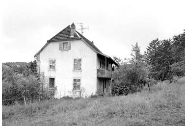
Logement patronal depuis l'ouest.
