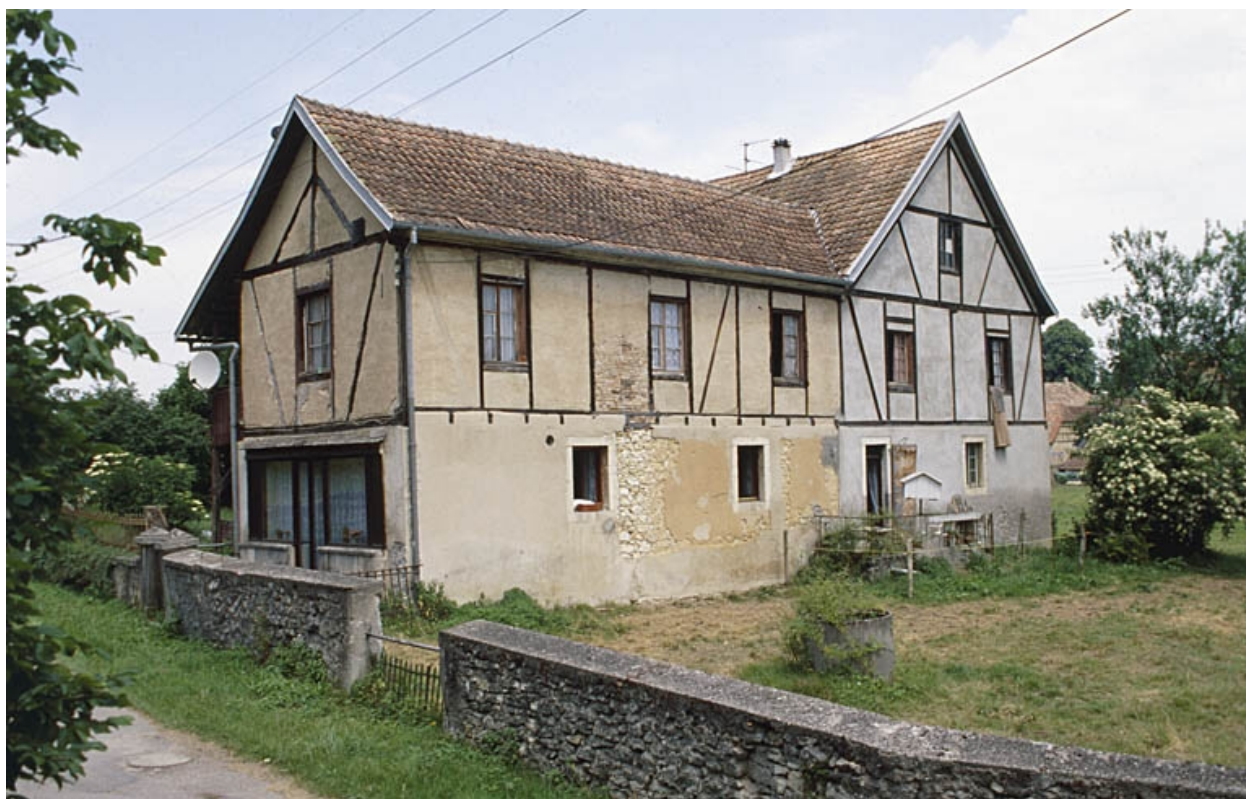
Façade postérieure du logement.
