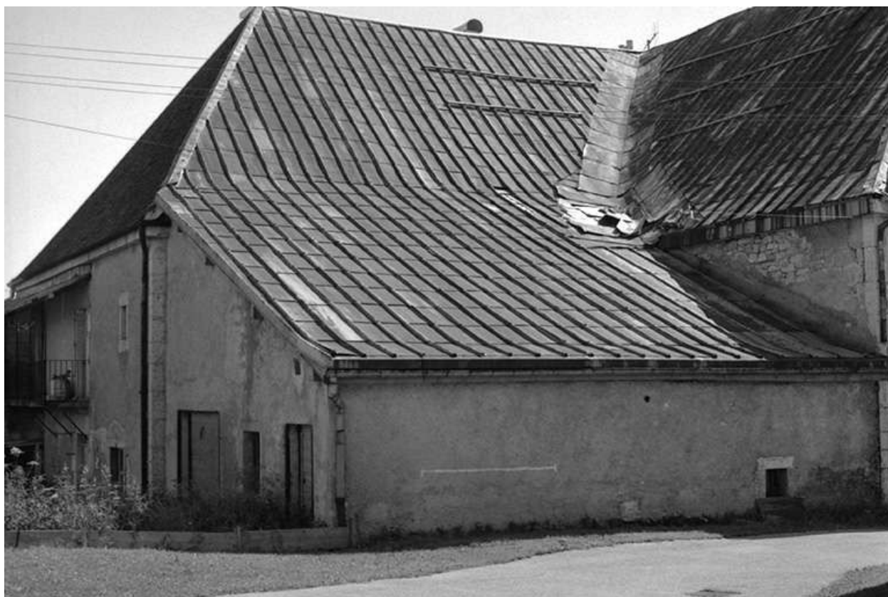
Façades postérieure et latérale droite.
