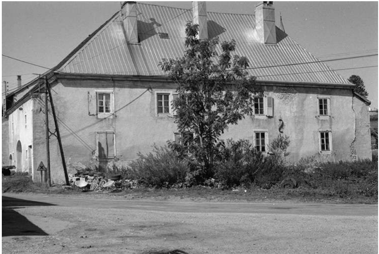
Façade latérale droite.
