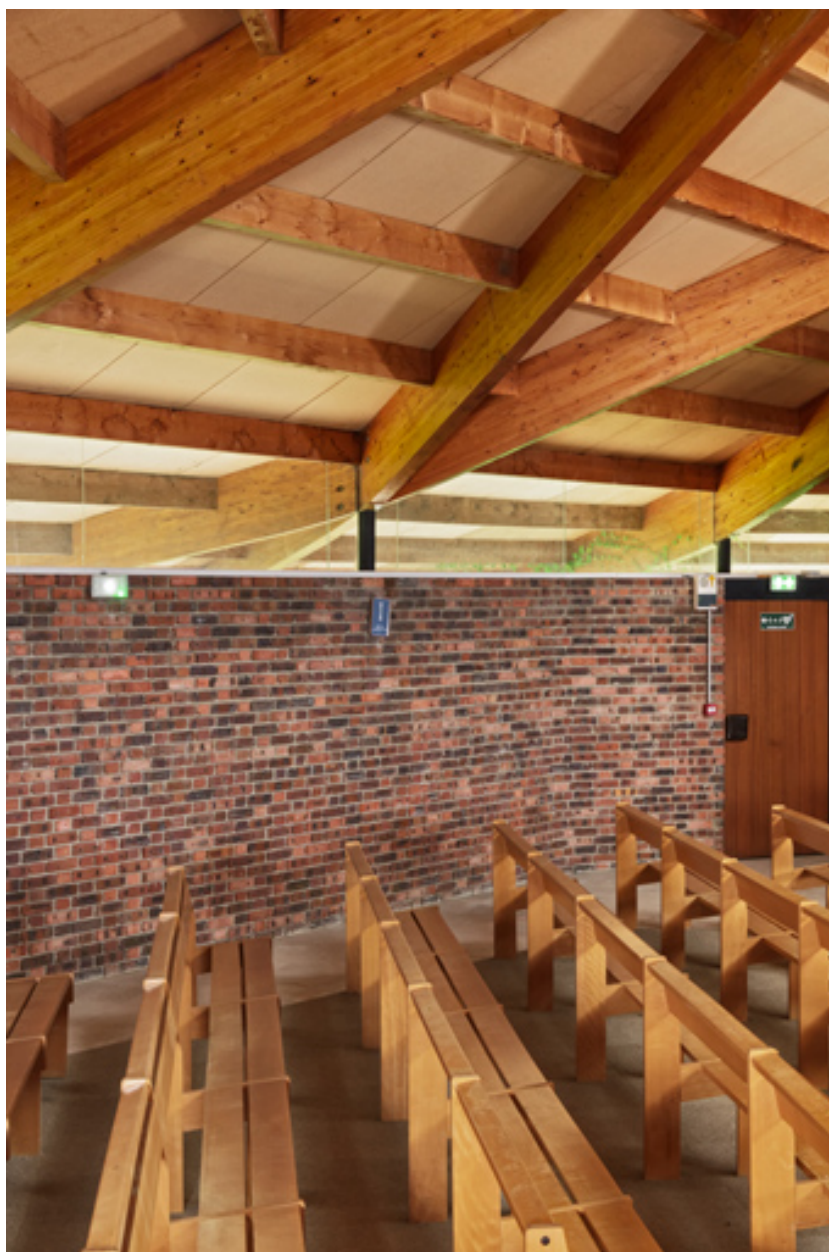
Charpente et entrée nord-est. Vue d'ensemble.
