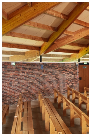
Charpente et entrée nord-est. Vue d'ensemble. Phot. Pierre-Marie Barbe-Richaud IVR26_20248900318NUC4A
