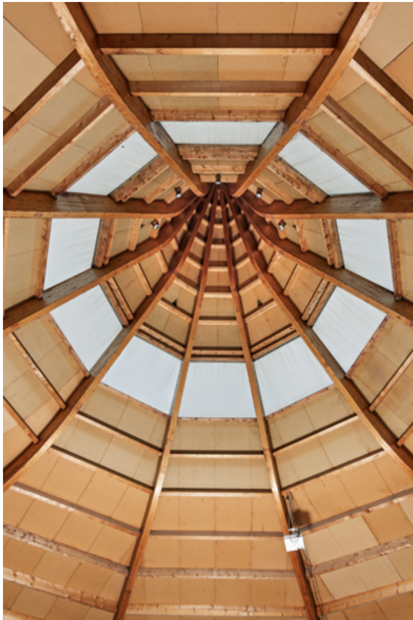
Couvrement et lanternon. Vue intérieure.
