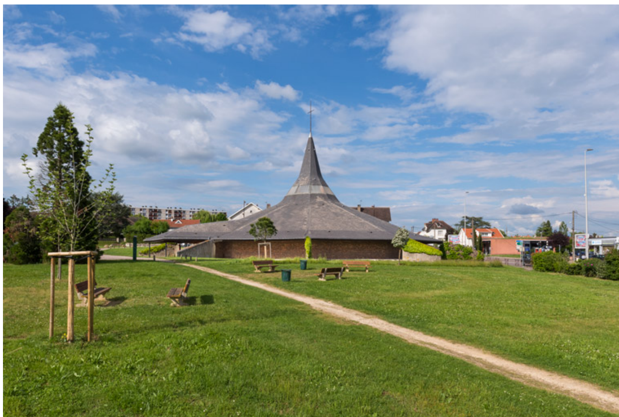
Vue depuis le sud.
