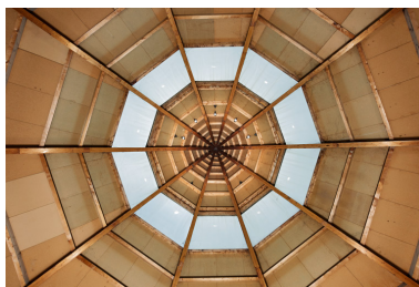
Lanternon. Vue en contre-plongée. Phot. Pierre-Marie Barbe-Richaud IVR26_20248900320NUC4A
