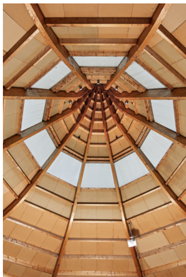
Couvrement et lanternon. Vue intérieure. Phot. Pierre-Marie Barbe-Richaud IVR26_20248900319NUC4A
