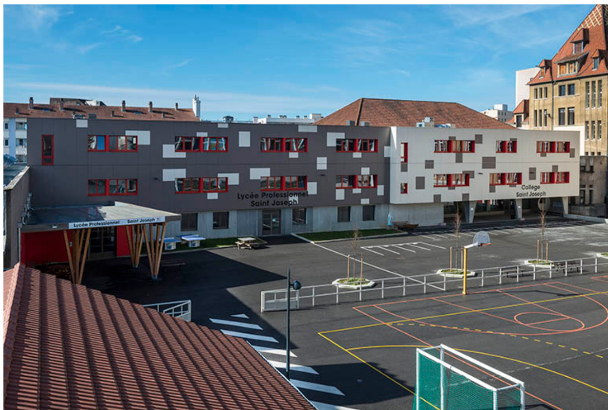
Extensions récentes du lycée.
