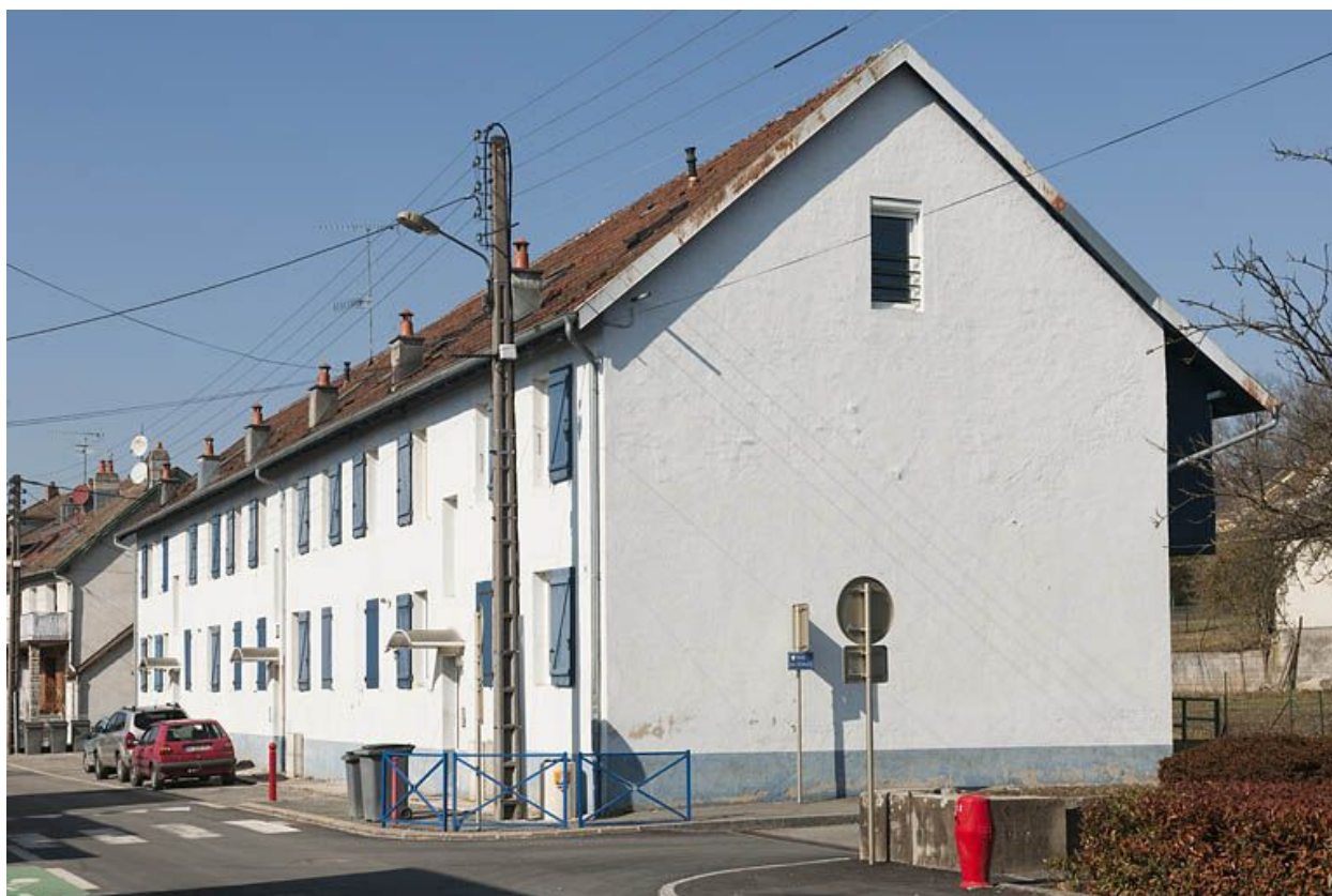
Immeuble de 12 logements vu depuis le sud-est.
