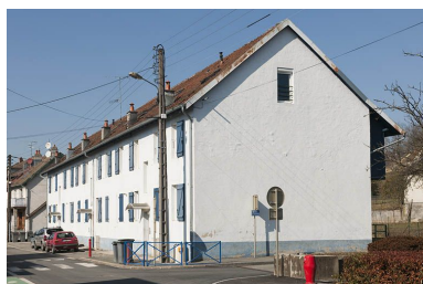
Immeuble de 12 logements vu depuis le sud-est. Phot. Jérôme Mongreville IVR43_20122500160NUC4A
