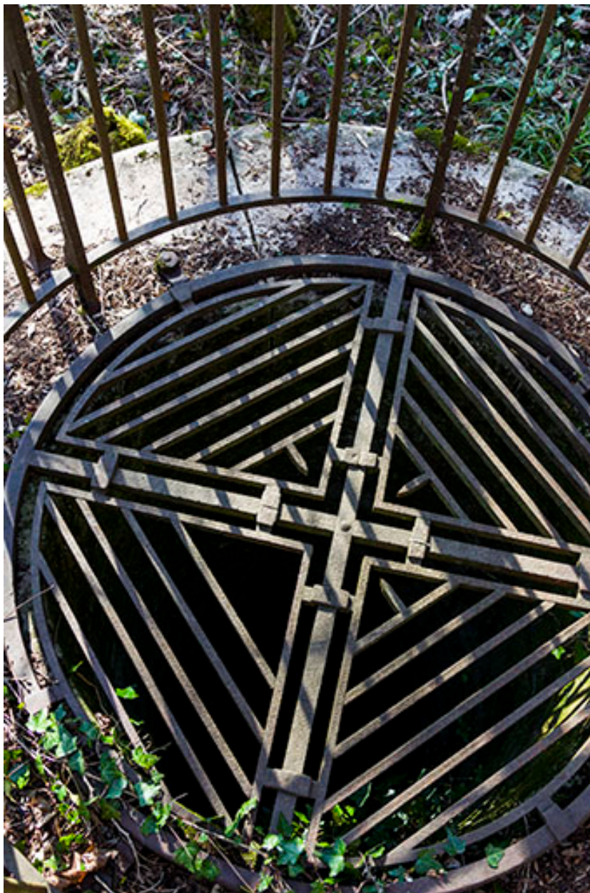
Grille de protection posée sur la margelle.
