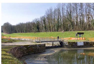
Entrée amont menant au tunnel. Phot. Sonia Dourlot IVR43_20157000236NUC2A
