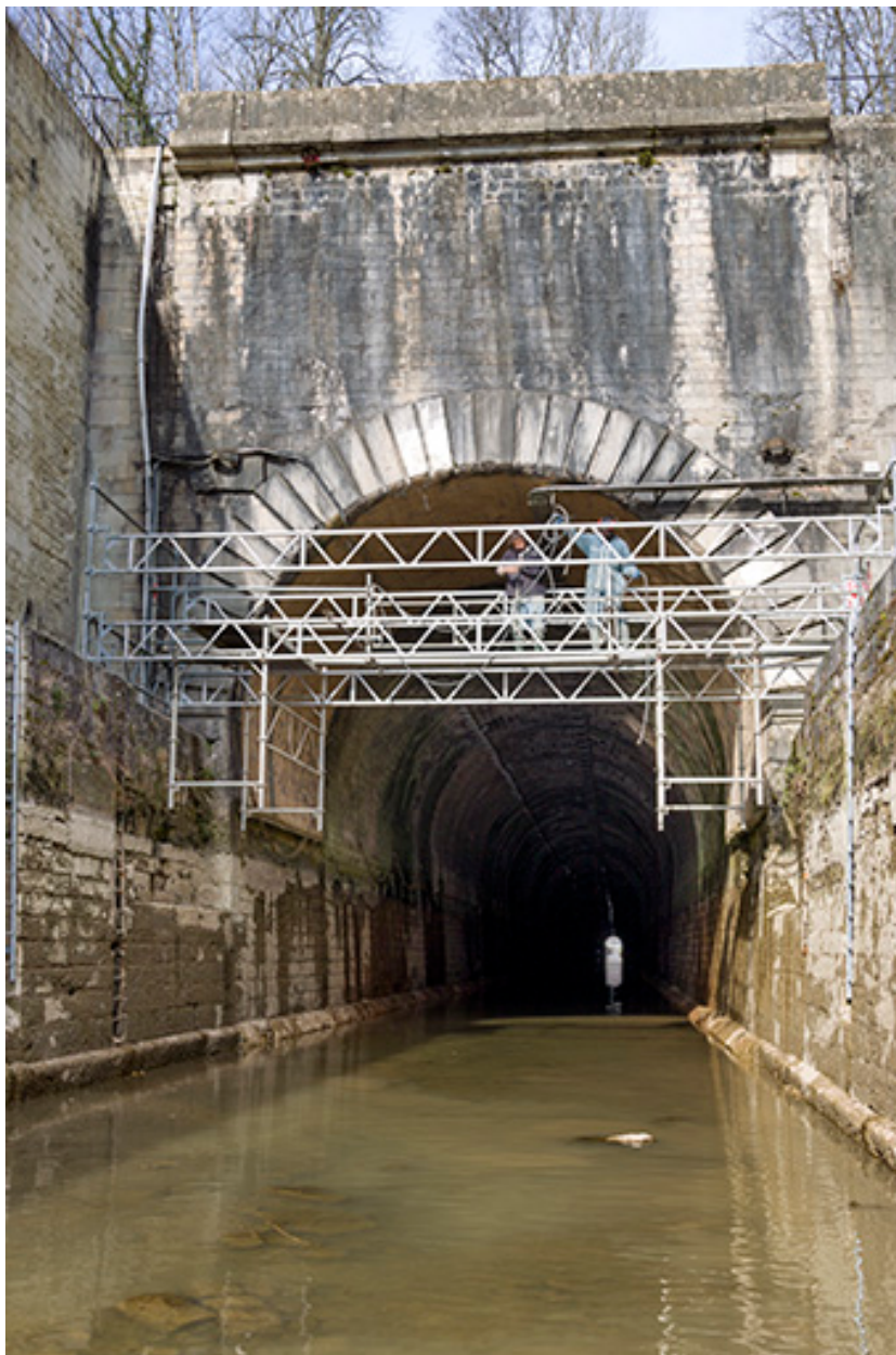
Entrée aval (restauration de la maçonnerie 2015).
