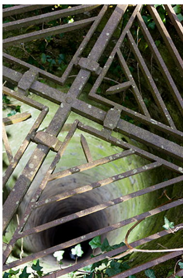
Vue du puits depuis l'orifice. Phot. Sonia Dourlot IVR43_20157000266NUC2A
