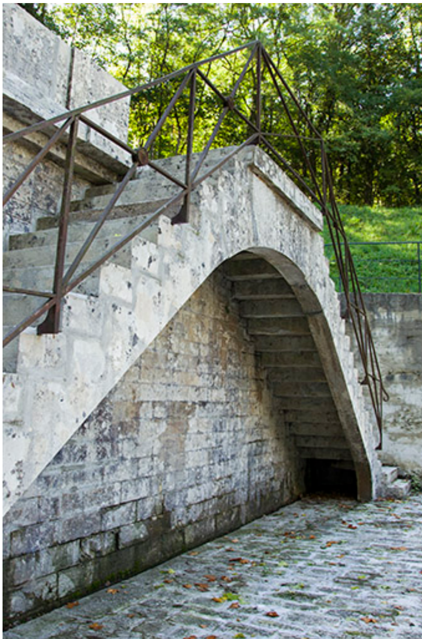
Escalier double, terrasse surplombant l'entrée du souterrain.
