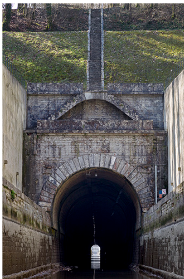
Entrée amont du souterrain. Phot. Sonia Dourlot IVR43_20157000246NUC2A
