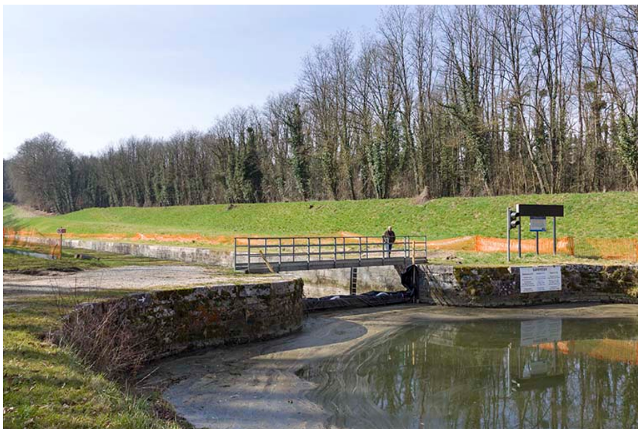
Entrée amont menant au tunnel.
