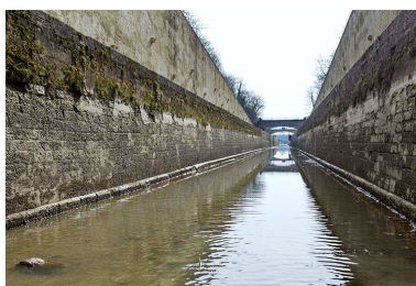
Le canal, vue prise depuis le radier. Phot. Sonia Dourlot IVR43_20157000259NUC2A
