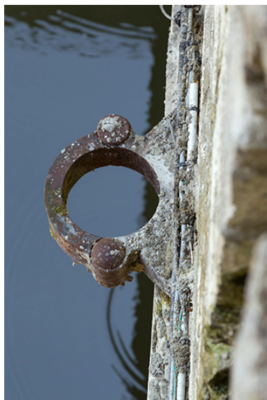
Gond d'une des anciennes portes du tunnel (entrée amont). Phot. Sonia Dourlot IVR43_20157001013NUC2A
