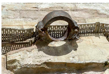
Gond d'une des anciennes portes du tunnel (entrée aval). Phot. Sonia Dourlot IVR43_20157001018NUC2A
