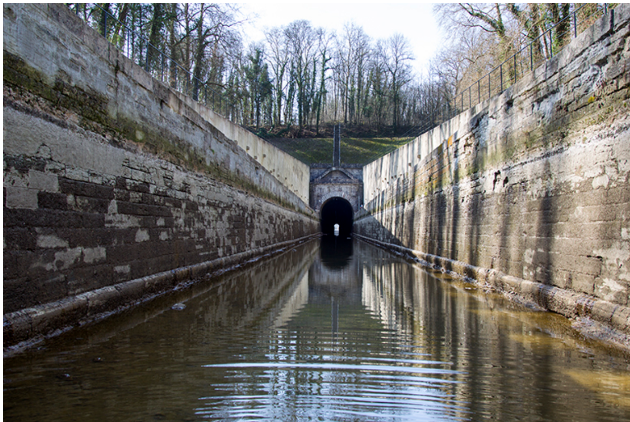
Le souterrain depuis la cuvette du canal.
