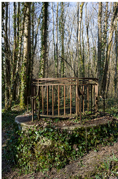
Puits d'aérage du tunnel. Phot. Sonia Dourlot IVR43_20157000265NUC2A
