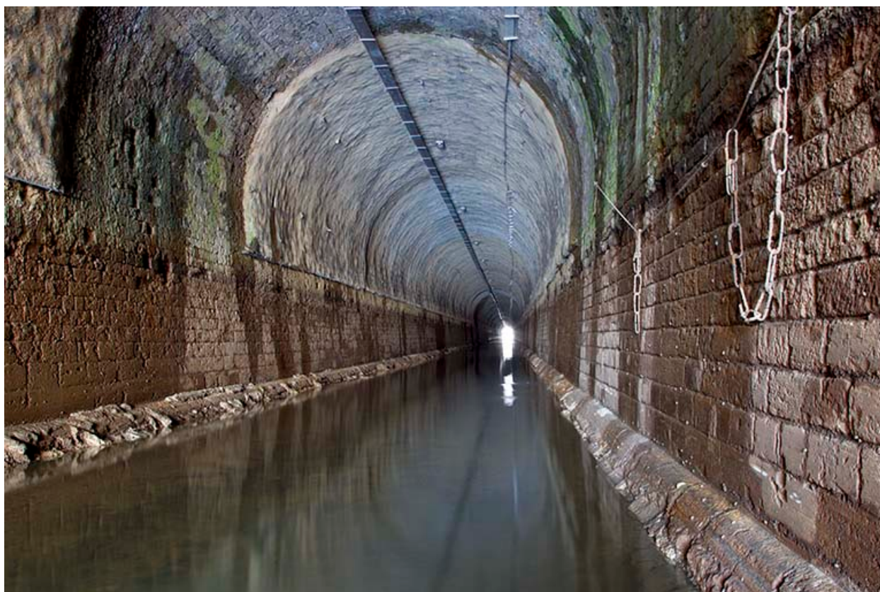
Intérieur du tunnel, vue générale.
