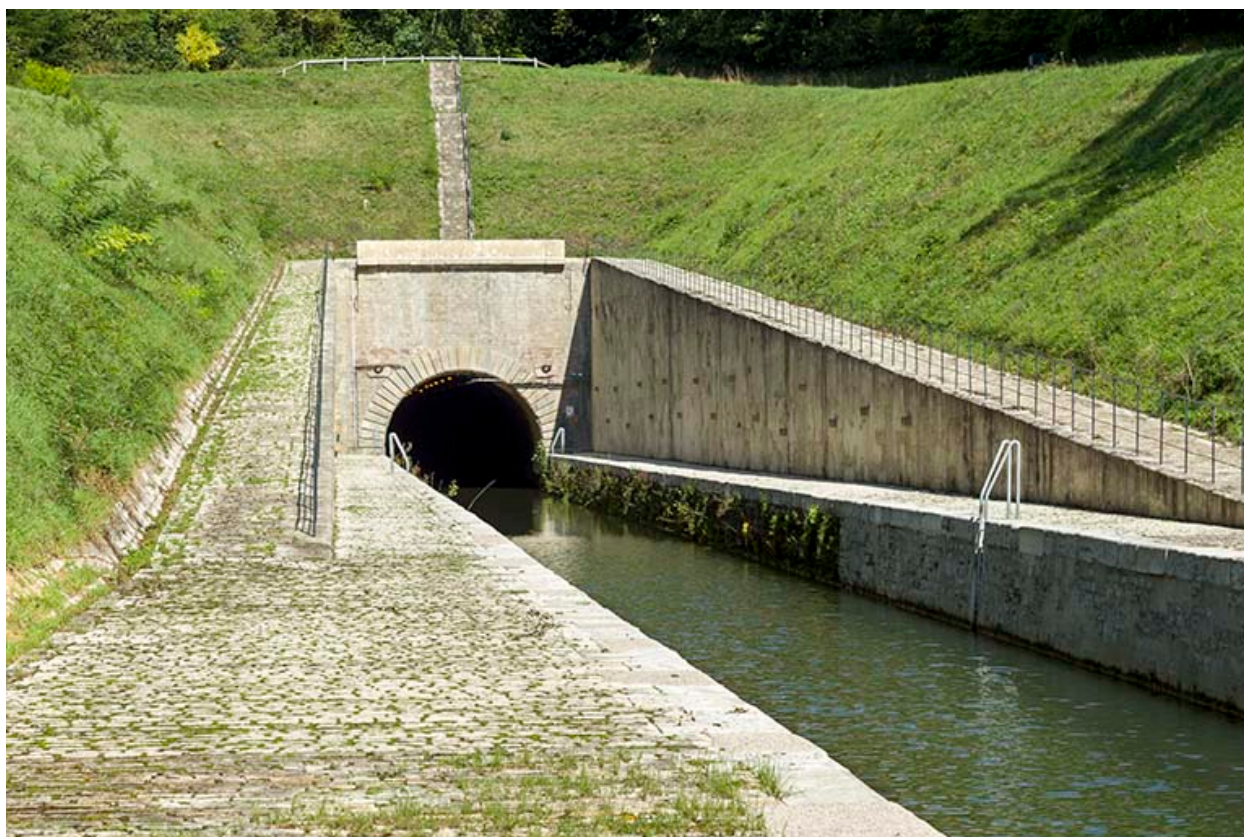
Entrée aval depuis le chemin de halage.
