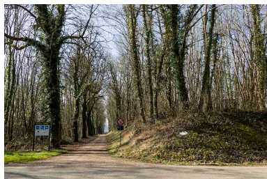
Remblai au dessus de l'ouvrage. Phot. Sonia Dourlot IVR43_20157000261NUC2A
